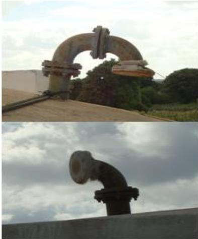
**Foto 58** – RAP-01: tubulações de ventilação com tela de proteção.
