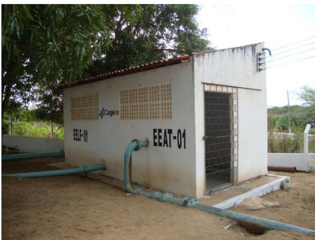
**Foto 45** – Vista externa da casa de abrigo das elevatórias EELF-01 e EEAT-01.
