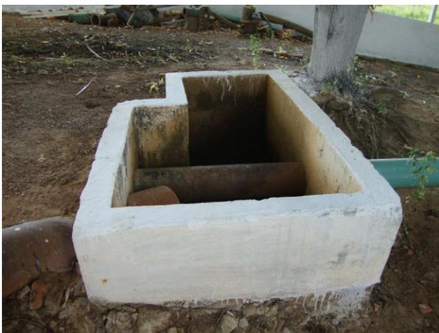
**Foto 38** – Caixa de descarga localizada na área da ETA.
