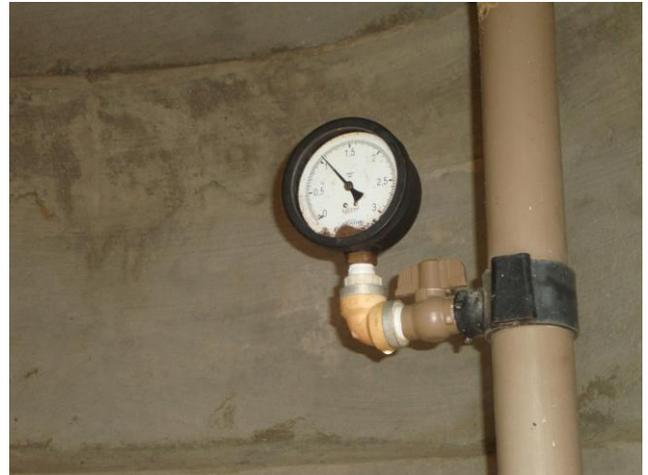
**Foto 67** – REL-02: medidor de nível.
