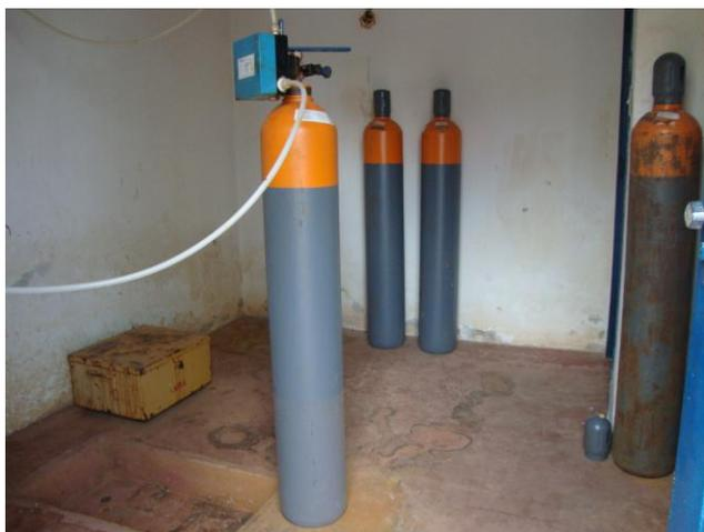
**Foto 23** – Dosador e acondicionamento dos cilindros de cloro gasoso.
