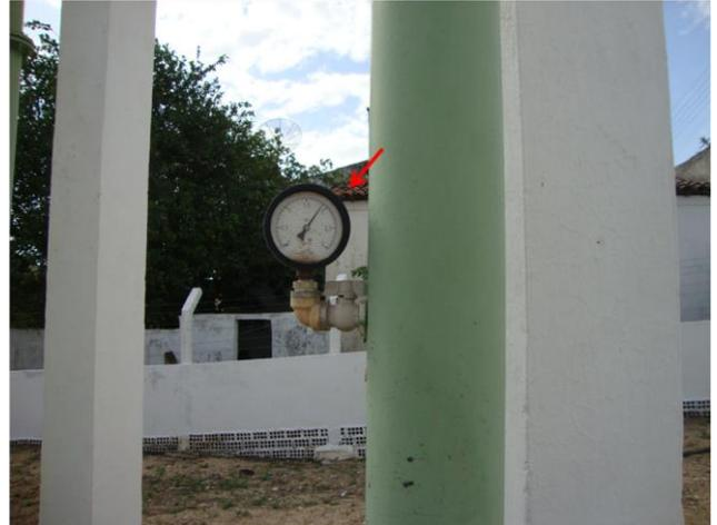
**Foto 65** – REL-01: medidor de nível.
