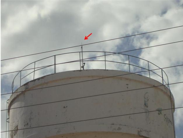
**Foto 64** – REL-01: guarda-corpos na laje de cobertura e para-raios.
