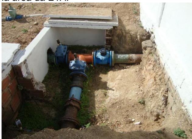
**Foto 41** – Registros e macromedidor de água tratada com caixa de proteção danificada, localizada na área do REL-01.
