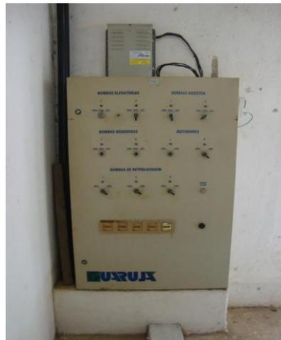
**Foto 48** – Quadro de comando das elevatórias EELF-01 e EEAT-01.
