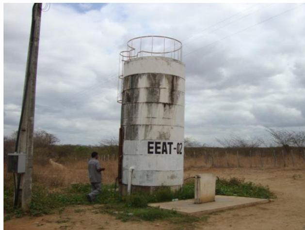
**Foto 50** – Vista externa da casa de abrigo da elevatória EEAT-02 sem cerca de proteção, localizada na localidade Itamaracá.
