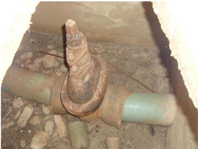
**Foto 36** – Caixa de registro de água tratada localizada entre a ETA e o REL-01
