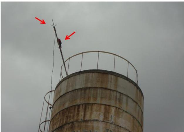
**Foto 68** – REL-02: guarda-corpos na laje de cobertura e para-raios.
