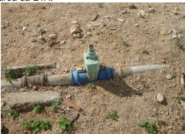
**Foto 40** – Registro de água tratada sem caixa de proteção, localizada na área do REL-01.
