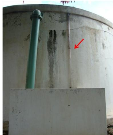
**Foto 59** – RAP-01: medidor de nível e tubulação de descarga.
