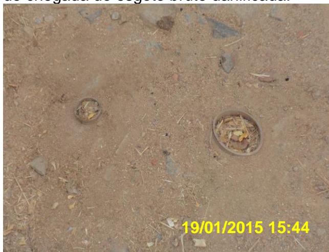
Foto 14 - RDA: Registro de descarga sem caixa na Rua Raimundo Cavalcante de Vasconcelos.
