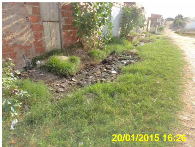
Foto 25 - Lançamento de esgoto a céu aberto no endereço da Rua 4, Bairro Casas Novas.
