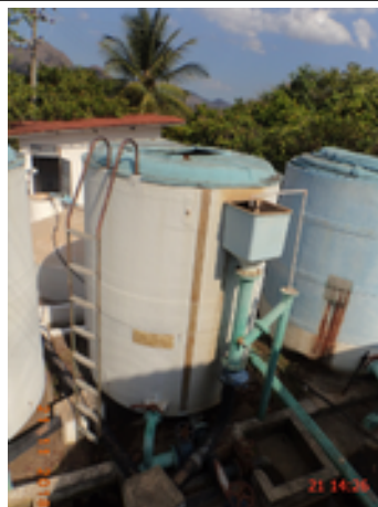
Foto 5 – ETA (Sede): Filtro F-03 sem tampa na calha de saída de água e tampa de inspeção aberta.
