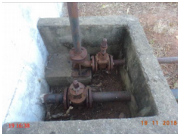
Foto 53 – RSE-01 (Sede): caixa de inspeção sem tampa ou grade de proteção.
