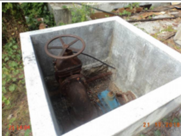
Foto 53 – RSE-01 (Sede): caixa de inspeção sem tampa ou grade de proteção.
