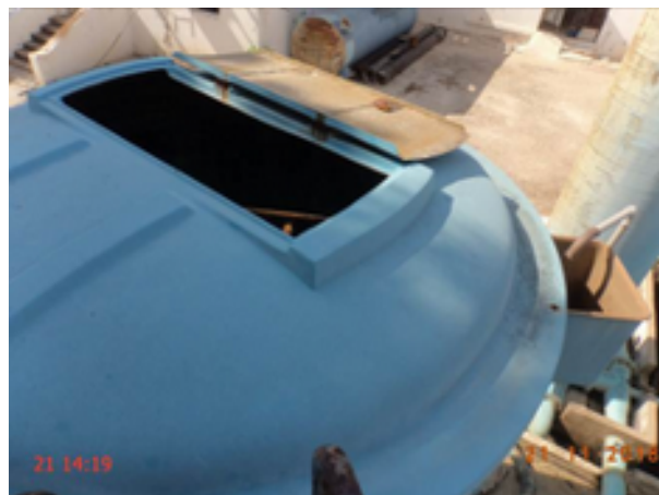
Foto 46 – ETA (Sede): F-12 tampa da abertura de inspeção aberta.
