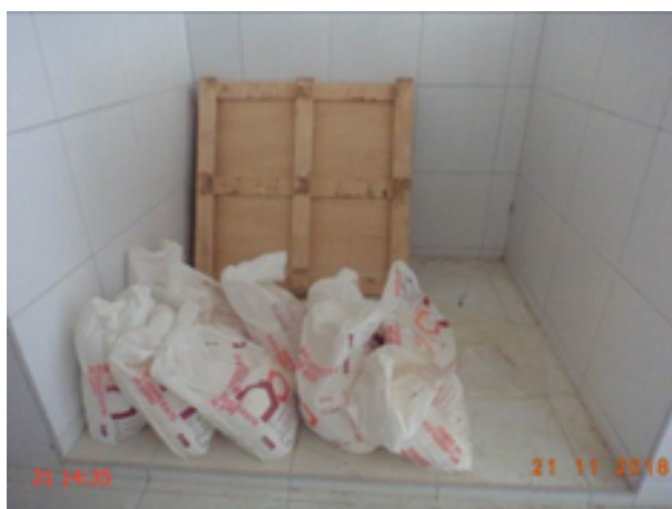
Foto 43 – ETA (Sede): fluossilicato de sódio armazenado diretamente em contato com o chão.
