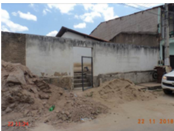
Foto 19 - EERD-01 (Sede): sem identificação.
