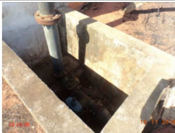
Foto 54 – RSE-01 (Sede): caixa de inspeção sem tampa ou grade de proteção.
