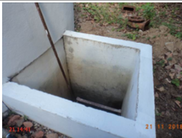
Foto 54 – RSE-01 (Sede): caixa de inspeção sem tampa ou grade de proteção.
