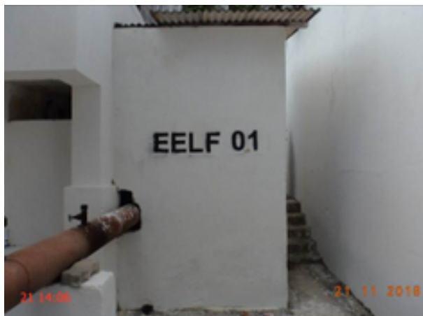
Foto 21 – EEAB-01 (Sede): identificada incorretamente.
