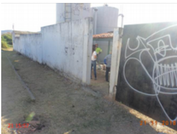
Foto 17 – ETE Prourb (Sede): ausência de identificação.
