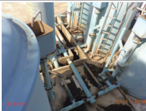
Foto 5 – ETA (Sede): Filtro F-03 sem tampa na calha de saída de água e tampa de inspeção aberta.
