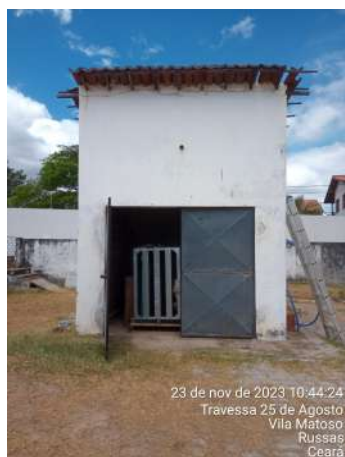
Foto 47 - EEE-03: casa do gerador, não possui identificação.
