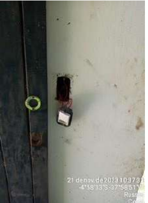
Foto 80 - Casa de Bombas (Sede): pintura danificada e rachaduras nas alvenarias, instalações elétricas precárias e interruptor quebrado.
