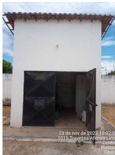
Foto 44 - EEE-04: casa do gerador/quadro sem identificação.
