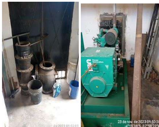
Foto 133 - EEE-6: sala do grupo gerador e do quadro de comando com materiais armazenados e vazamento no registro.
