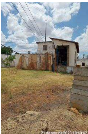
Foto 78 - Casa de Bombas (Sede): pintura danificada e rachaduras nas alvenarias, instalações elétricas precárias com fiação externa baixa.
