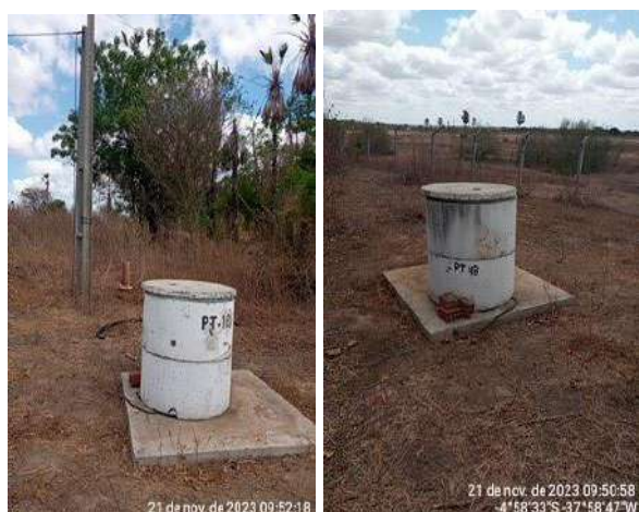
Foto 64 - PT-48 (Sede): fiação elétrica sobre o solo e o poço possui duas numerações (PT-48 e PT-16).
