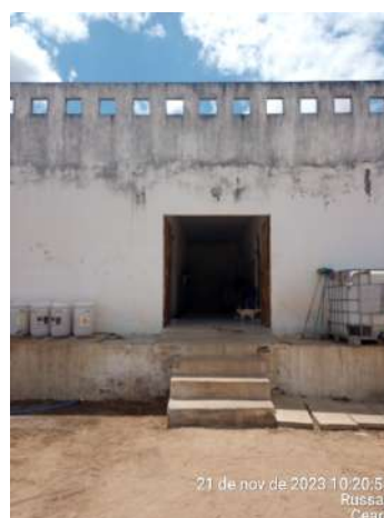
Foto 22 - Laboratório / Casa de Química (Sede): ausência de identificação.
