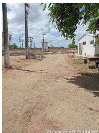
Foto 147 - Captação (Pedro Ribeiro): áreas principais de trânsito dos operários sem pavimentação.
