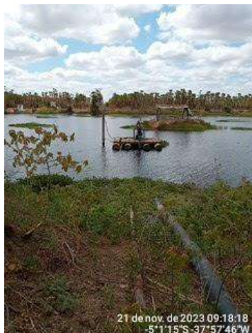
Foto 142 - - Captação (Sucurujuba): área sem isolamento.
