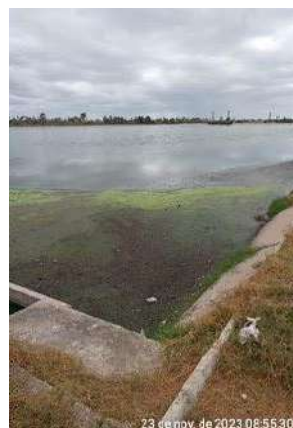
Foto 123 - Lagoa facultativa: lagoa assoreada na entrada do efluente e excesso de sobrelençantes.
