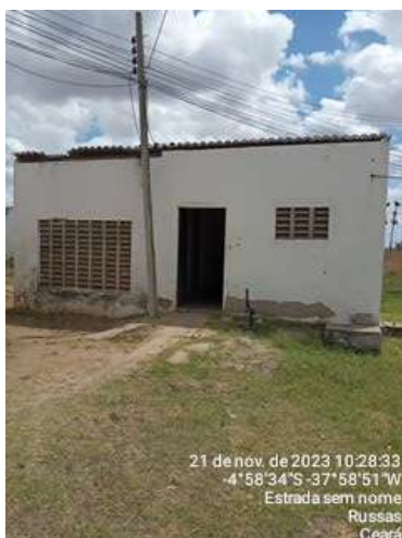
Foto 17 - Casa de Macromedição 2 (Sede): ausência de identificação.
