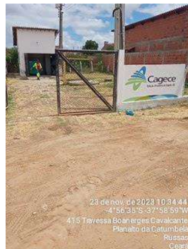
Foto 46 - EEE-02: casa do gerador/quadro sem identificação.
