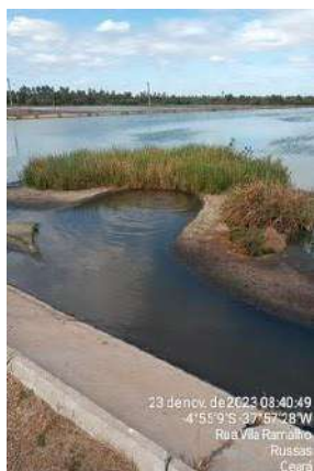
Foto 122 - Lagoa facultativa: lagoa assoreada na entrada do efluente e excesso de sobrelençantes.
