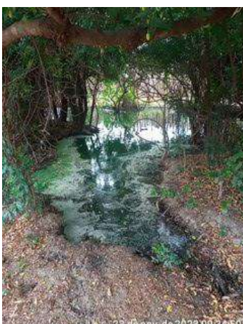
Foto 130 - Corpo Receptor: esgoto represado no Riacho Araibu, possível obstrução do córrego / riacho.
