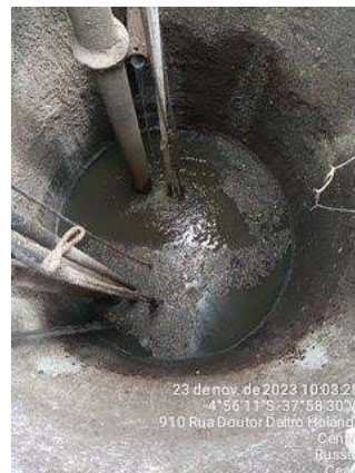
Foto 135 - EEE-4: sobrenadantes no poço de sucção.
