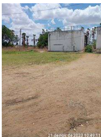
Foto 146 - Captação (Pedro Ribeiro): áreas principais de trânsito dos operários sem pavimentação.
