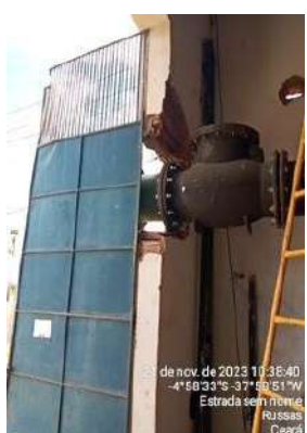
Foto 80 - Casa de Bombas (Sede): pintura danificada e rachaduras nas alvenarias, instalações elétricas precárias e interruptor quebrado.
