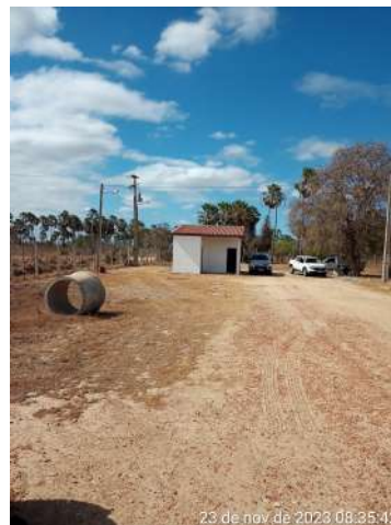
Foto 38 - Casa do Operador (ETE-Russas): sem identificação.
