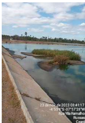
Foto 122 - Lagoa facultativa: lagoa assoreada na entrada do efluente e excesso de sobrelençantes.
