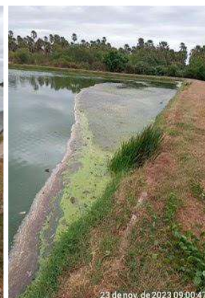
Foto 123 - Lagoa facultativa: lagoa assoreada na entrada do efluente e excesso de sobrelençantes.
