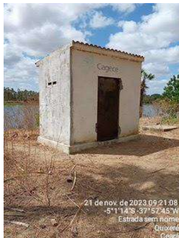
Foto 143 - - Captação (Sucurujuba): área sem isolamento.
