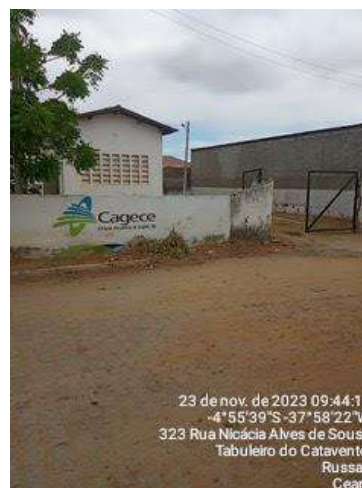
Foto 40 - EEE-06: ausência de identificação.
