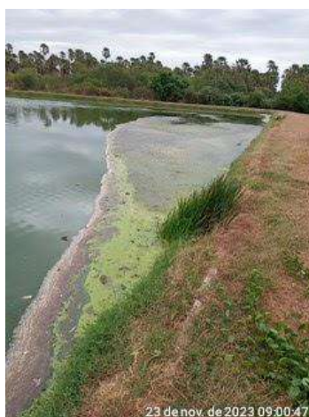
Foto 125 - Lagoa de Maturação: excesso de sobrelençantes.
