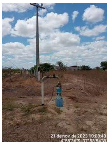
Foto 15 - PT-41 (Sede): tubo de revestimento sem tampa.
