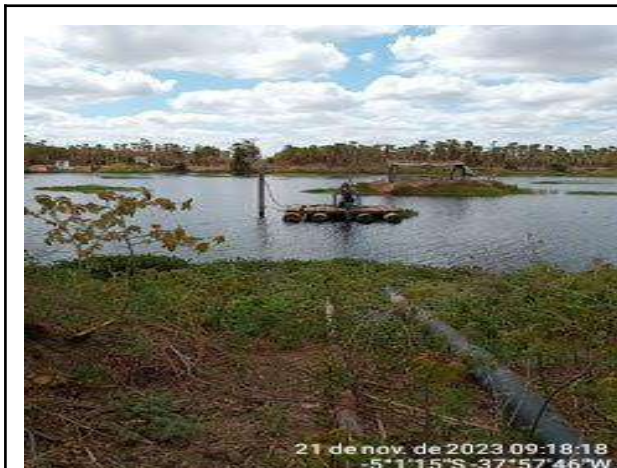
Foto 1 - Captação (Sucurujuba) (Sede): falta placa identificando área de captação para abastecimento humano.
