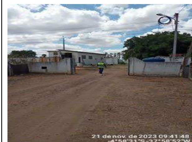
Foto 3 - Captação (Pedro Ribeiro) (Sede): ausência de identificação.
