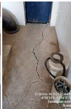
Foto 79 - Casa de Bombas (Sede): pintura danificada e rachaduras nas alvenarias e piso, interruptor quebrado e local sendo utilizado para armazenar materiais.
