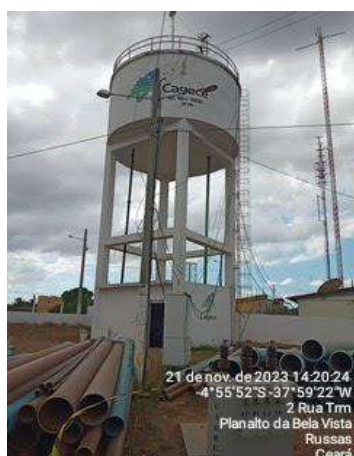
Foto 88 - REL (ETA) (Sede): fiação elétrica inadequada, fora dos padrões de instalação.
