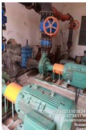
Foto 78 - Casa de Bombas (Sede): pintura danificada e rachaduras nas alvenarias, instalações elétricas precárias com fiação externa baixa.
