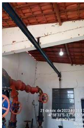
Foto 79 - Casa de Bombas (Sede): pintura danificada e rachaduras nas alvenarias e piso, interruptor quebrado e local sendo utilizado para armazenar materiais.
