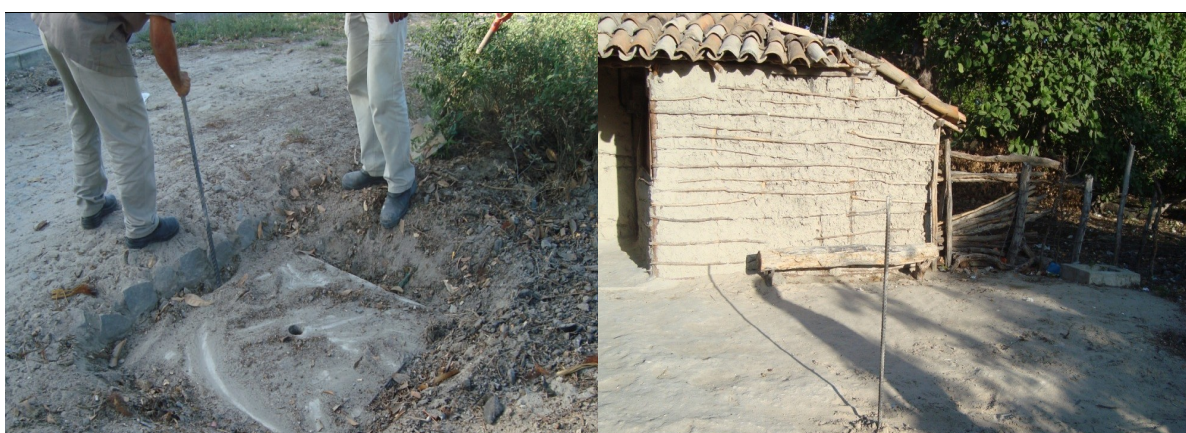
Foto 31 – Local de escavação para a retirada do CAP da rede, para realização de descarga, na Rua Vila Nova, fns 381.
