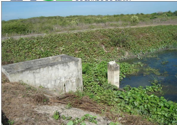
Foto 34 – ETE do SES de Barroquinha: taludes e lagoas tomados pela vegetação.
