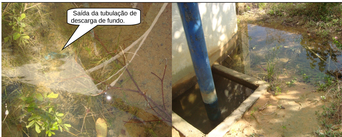
Foto 24 – Saída da tubulação de descarga de fundo do REL-06, utilizada na lavagem e desinfecção do reservatório.
