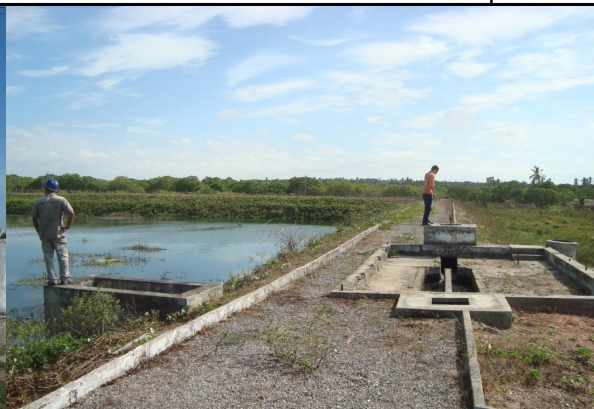
Foto 33 – ETE do SES de Barroquinha.
