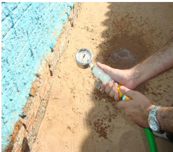
Foto 79 – Medição de pressão na Rua Cícero Teixeira, nº 200 – Sede.
