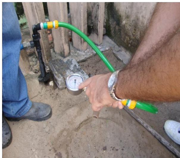
Foto 80 – Medição de pressão na Rua Raimundo Gurgel Maia, nº 24 – Sede.
