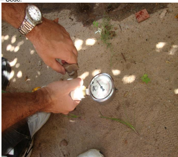
Foto 81 – Medição de pressão na Rua Francisco Agostinho, nº 469 – Sede.
