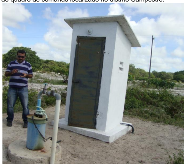
Foto 28 – Vista do PT-22 com casa de proteção do quadro de comando, localizado no distrito Campestre.
