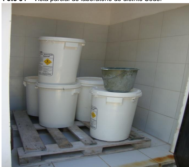
Foto 36 – Armazenamento de produtos químicos do distrito Sede.
