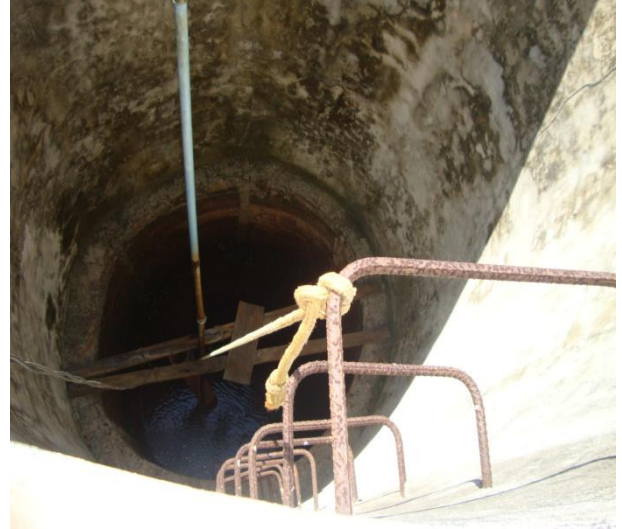
Foto 2 – Vista interna do PA-01 localizado no distrito Sede.
