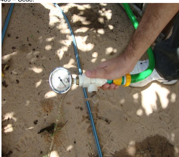
Foto 83 – Medição de pressão na Rua João Sapuruna, nº 222 – Barra.
