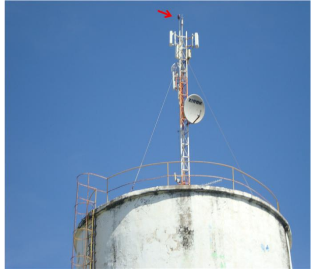
Foto 68 – REL-02: Com existência de para-raios e sinalizador.
