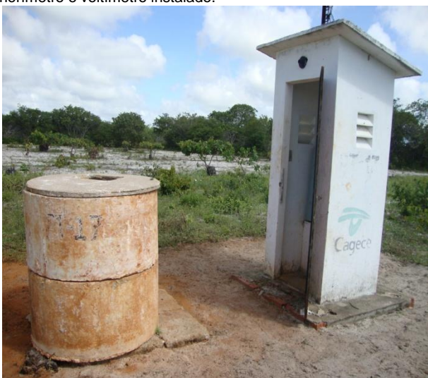
Foto 23 – Vista do PT-17 com casa de proteção do quadro de comando, localizado no distrito Campestre.
