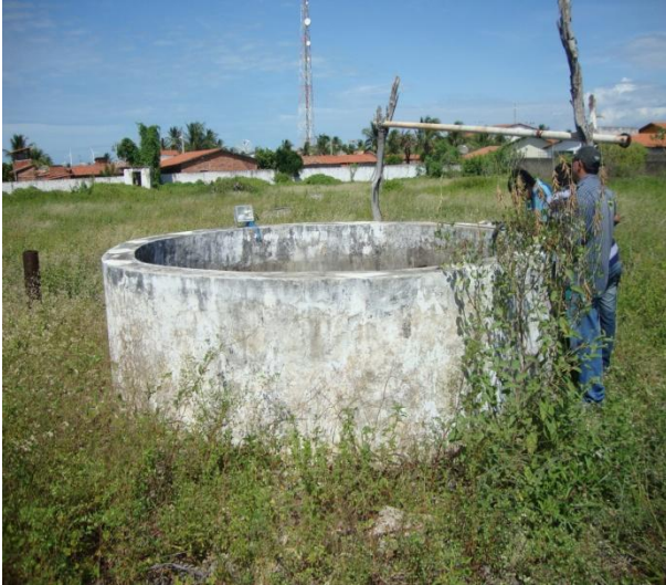
Foto 1 – Vista externa do PA-01 localizado no distrito Sede.
