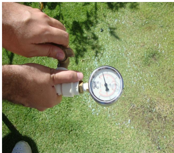
Foto 86 – Medição de pressão na Rua Vicente Silvano, Igreja – Maceió.
