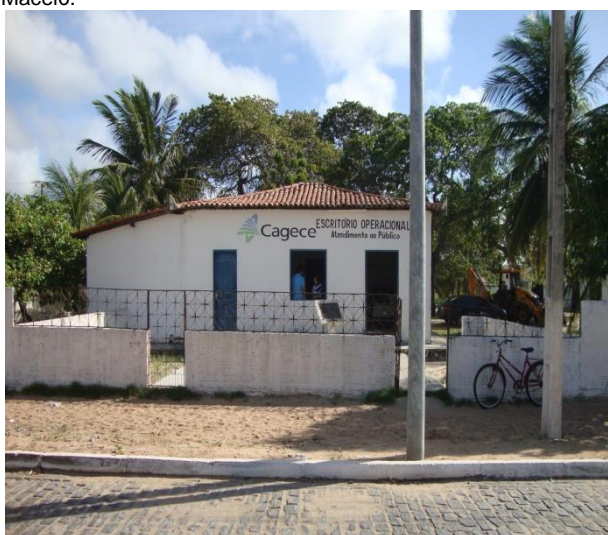
Foto 87 – Vista externa do escritório/loja de atendimento ao usuário
