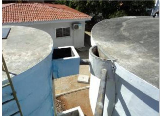
**Foto 18** – Filtros F01: calha de saída de água sem tampa.
