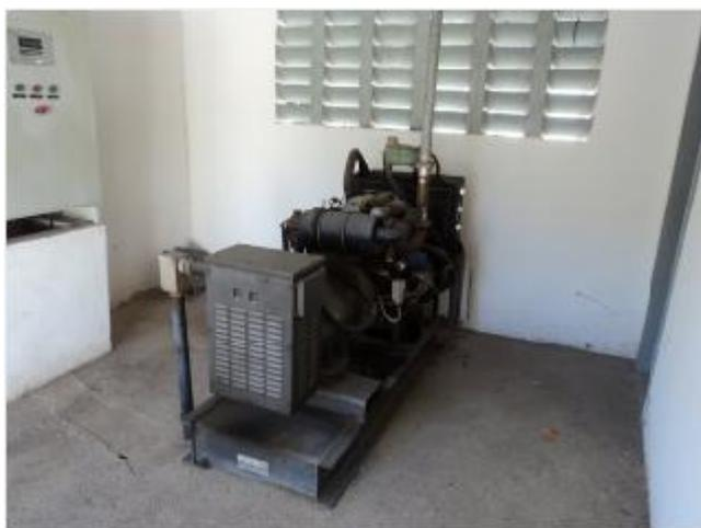
**Foto 87** – EEE-02: grupo gerador de energia elétrica sem funcionar.
