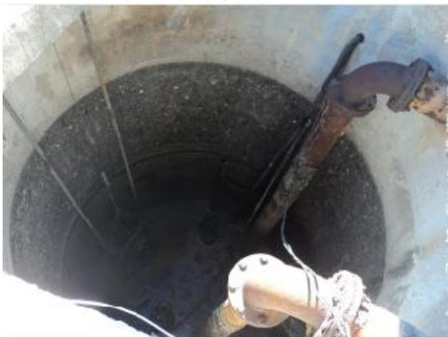
**Foto 85** – EEE-02: vista interna do poço de sucção – sistema de içamento da grade para reter os materiais sólidos encontra-se danificado.
