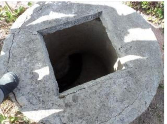
**Foto 128** – ETE-Choró: caixa de inspeção de chegada do esgoto na lagoa facultativa sem tampa.
