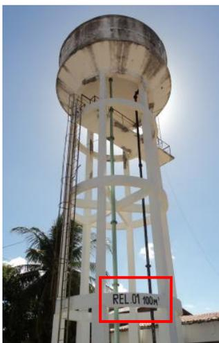
**Foto 49** – REL-01: identificação e escadas com guarda-corpos deteriorados a serem substituídos.
