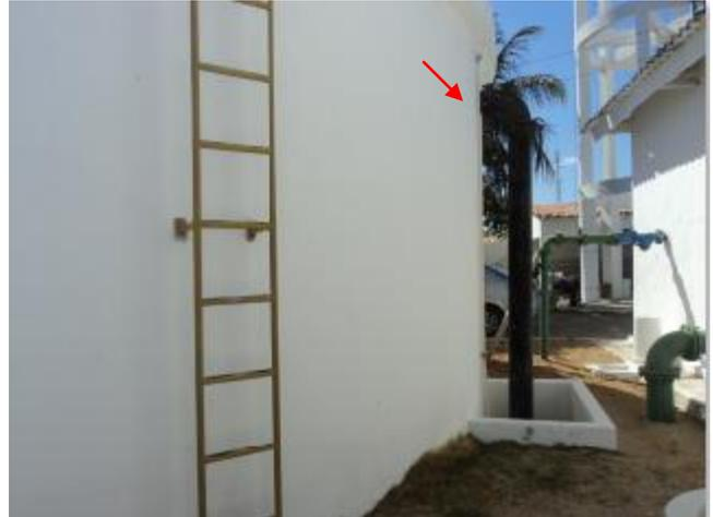
**Foto 46** – RAP-01: escada e medidor de nível.
