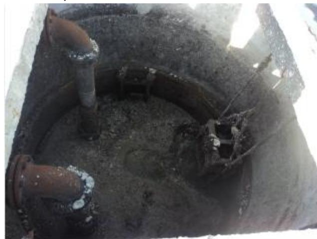
**Foto 74** – EEE-01: poço de sucção com bombas submersas e sem tampa.
