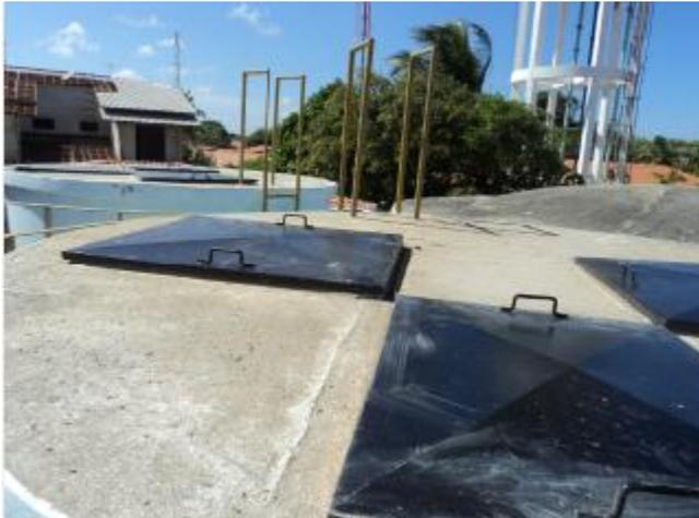
**Foto 17** – Filtros F01 e F02: tâmpas de inspeção.
