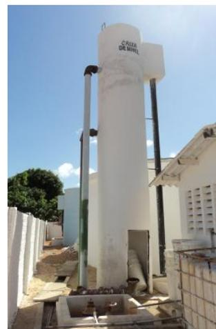
**Foto 10** – ETA: caixa de nível – chegada da água.
