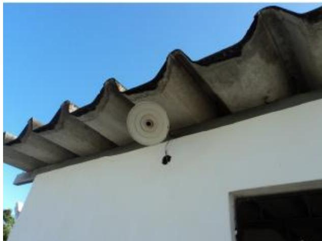
**Foto 78** – EEE-01: ausência de iluminação externa.
