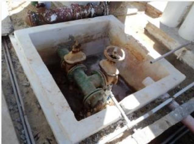
**Foto 11** – ETA: tubulação de chegada na caixa de nível sem tampa ou grade de inspeção.
