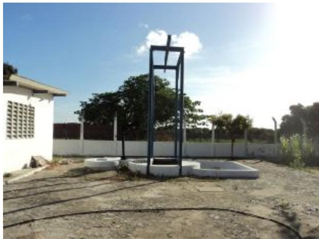
**Foto 72** – EEE-01: vista geral do tratamento, condições de conservação e poço de sucção sem tampa.
