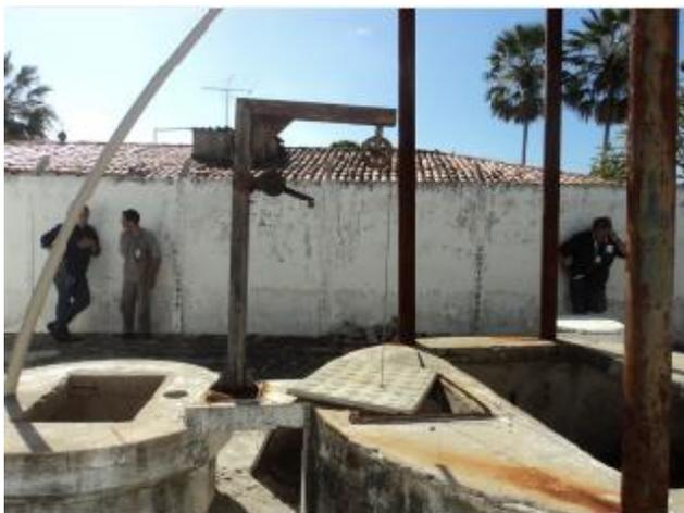
**Foto 83** – EEE-02: poço de chegada do esgoto e poço de sucção sem tampas.
