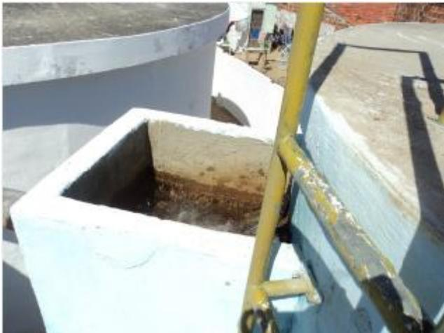
**Foto 19** – Filtros F02: calha de saída de água sem tampa.
