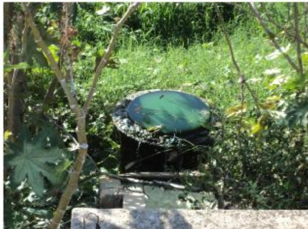
**Foto 119** – ETE-Beberibe: estravassamento na caixa de saída do esgoto.
