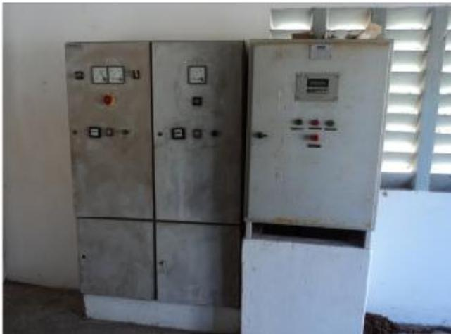
**Foto 77** – EEE-01: quadro de comando das bombas e do grupo gerador de energia elétrica.
