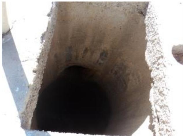
**Foto 84** – EEE-02: vista interna do poço de chegada do esgoto.
