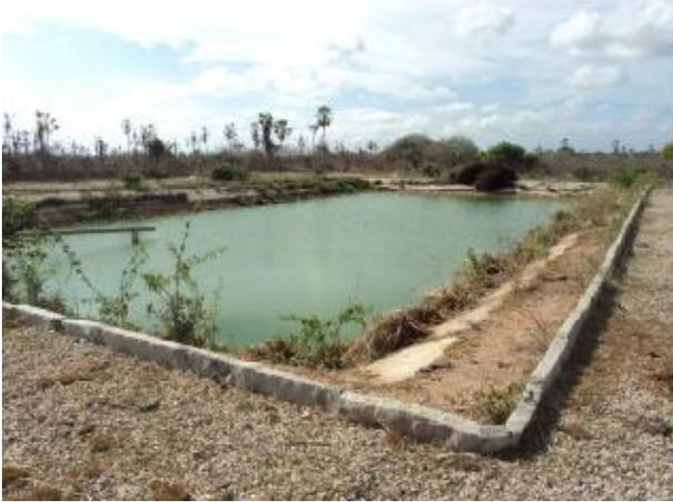
**Foto 130** – ETE-Choró: vista geral da lagoa de maturação 1 – taludes deteriorados e cobertos por vegetação.
