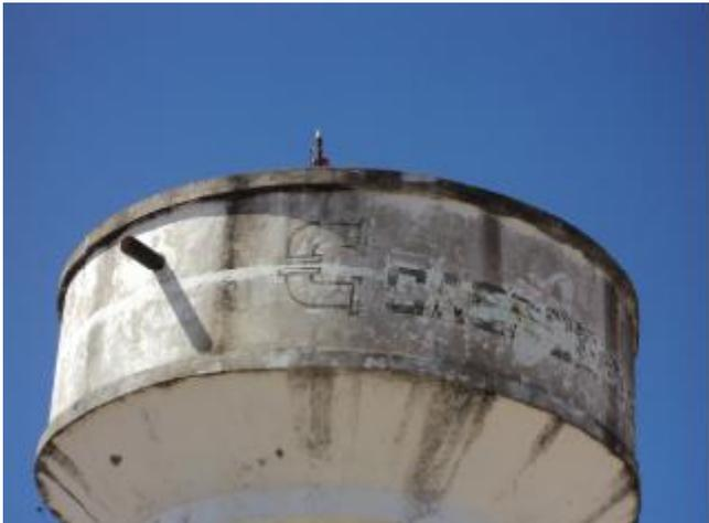
**Foto 51** – REL-01: pintura deteriorada, para-raios e sinalização noturna.
