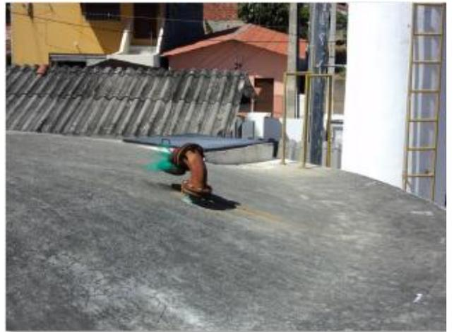
**Foto 48** – RAP-01: tubulação de ventilação com tela de proteção e tampa de inspeção.
