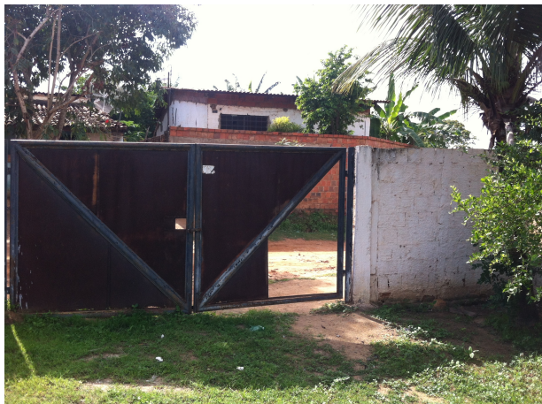
Foto 7 - ETE PROURB II: portão danificado e ausência de identificação
