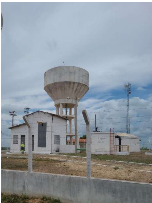
Foto 11 REL-01: Ausência de guarda-corpo.
