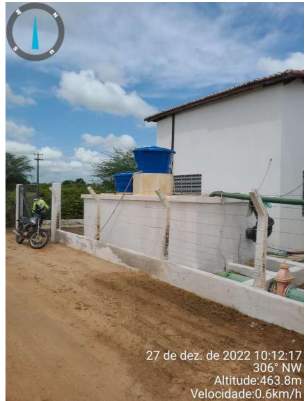
Foto 2 RAP-04: Sem identificação.
