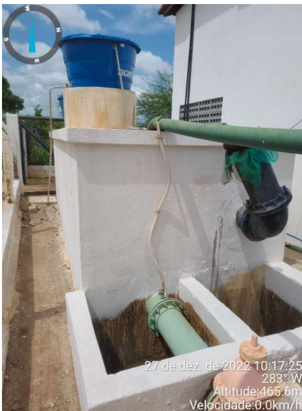
Foto 3 RAP-04: Sem identificação.
