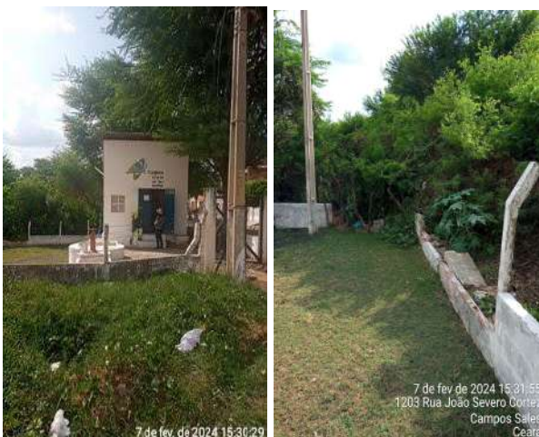
Foto 56 - EEE-02: cerca de isolamento e proteção danificada.
