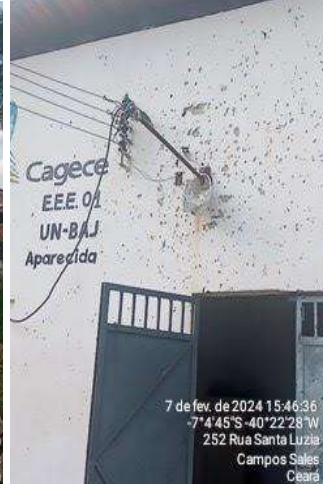
Foto 61 - EEE-01: não há grupo gerador instalado; muro de isolamento e proteção danificado e pintura deteriorada.
