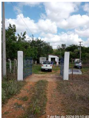
Foto 1 - Captação açude Poço da Pedra: ausência de identificação.
