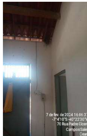
Foto 65 - EEE-06: banheiro sem iluminação; tomada elétrica danificada.
