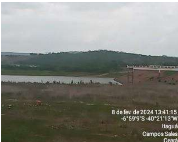
Foto 76 - Manancial - açude Poço da Pedra, com cota correspondente a menos de 10% do seu volume útil armazenado.
