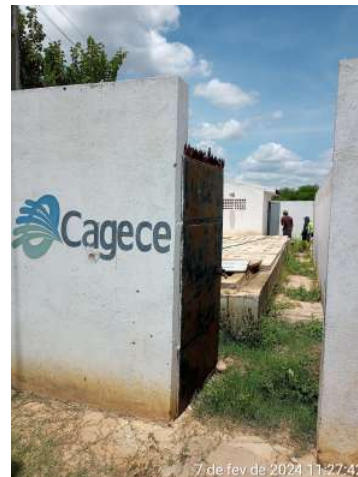
Foto 16 - REN-01: o reservatório e casa de bombas não possuem identificação.
