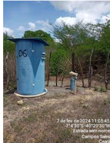
Foto 6 - PT-06: poço desativado e sem tamponamento adequado.
