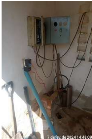
Foto 50 - EEAT-03/RAP-02: instalações elétricas inadequadas; tampa do reservatório corroída; pintura desgastada e infraestrutura deteriorada (paredes e pisos).
