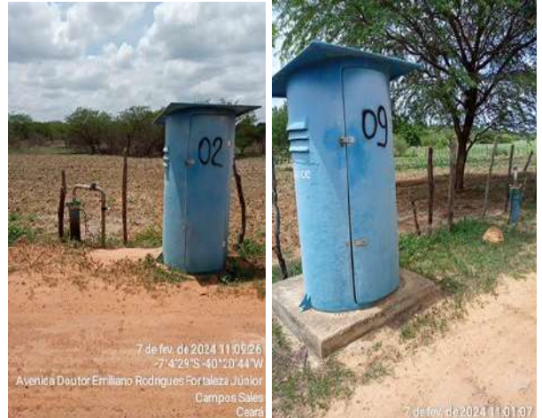
Foto 4 - PT-02 e PT-09: área do poço sem isolamento de proteção ao acesso e poço não possui laje de proteção.
