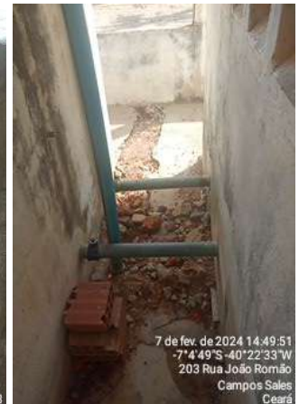
Foto 51 - EEAT-03/RAP-02: instalações elétricas inadequadas; tampa do reservatório corroída; ventilação danificada; pintura desgastada e infraestrutura deteriorada (paredes e pisos).
