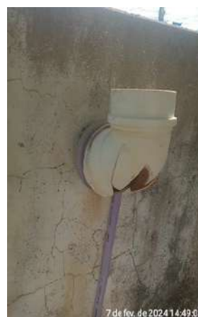
Foto 51 - EEAT-03/RAP-02: instalações elétricas inadequadas; tampa do reservatório corroída; ventilação danificada; pintura desgastada e infraestrutura deteriorada (paredes e pisos).
