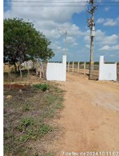
Foto 10 - ETA: ausência de identificação.
