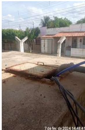
Foto 50 - EEAT-03/RAP-02: instalações elétricas inadequadas; tampa do reservatório corroída; pintura desgastada e infraestrutura deteriorada (paredes e pisos).
