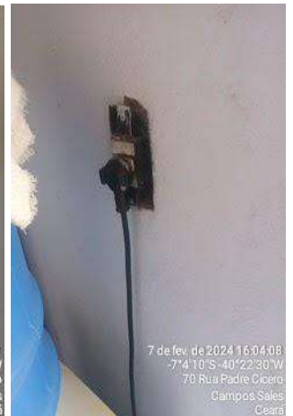
Foto 65 - EEE-06: banheiro sem iluminação; tomada elétrica danificada.
