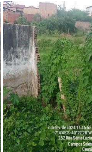
Foto 62 - EEE-01: muro de isolamento e proteção danificado e pintura deteriorada.
