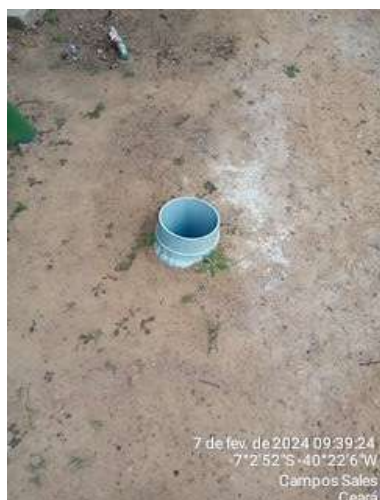
Foto 22 - ETA: caixa de proteção de registro danificada.
