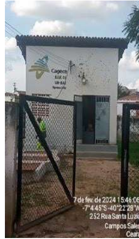
Foto 61 - EEE-01: não há grupo gerador instalado; muro de isolamento e proteção danificado e pintura deteriorada.
