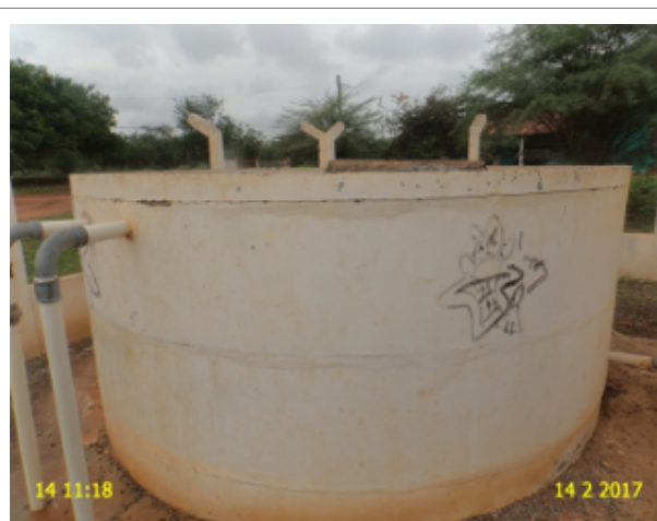
Foto 4 – RAP-03: ausência de identificação e medidor de nível.
