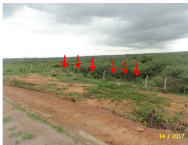
Foto 34 – ETE: cerca danificada.
