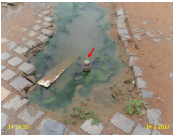
Foto 18 – RDA: registro de descarga sem caixa na Rua Pereira Filgueiras – Bairro Batalhão.
