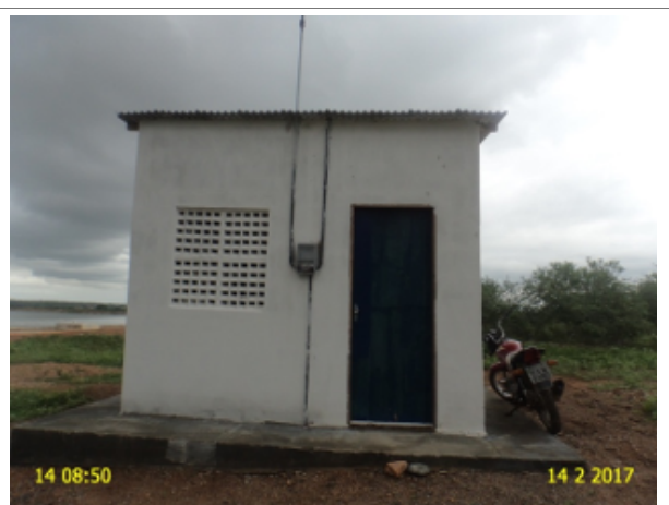
Foto 10 – ETE: casa de abrigo com instalações para iluminação, porém não há interligação com a energia elétrica.
