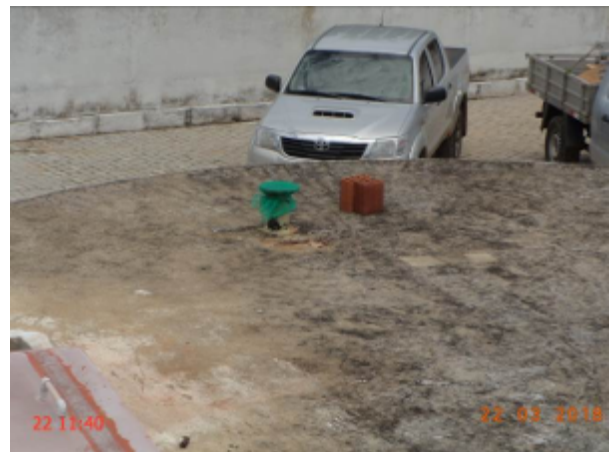
Foto 45 – RAP-01 (Serra do Félix): tubulação de ventilação inadequada.
