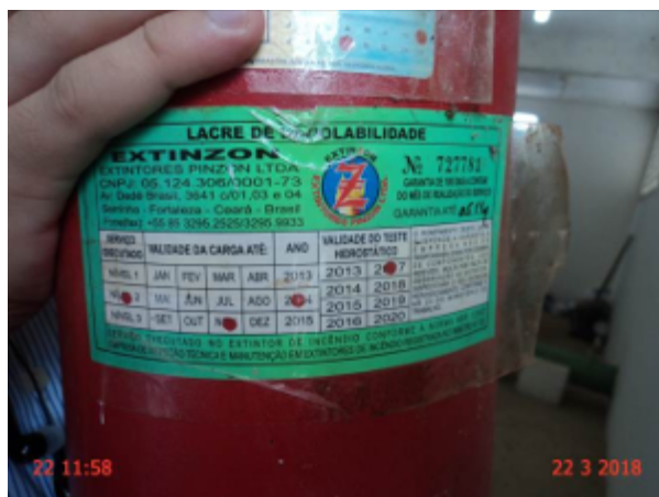
Foto 21 – ETA – Casa de Bomba (Serra do Félix): extintor de incêndio com validade da recarga e do teste do cilindro vencida.
