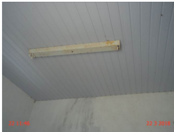
Foto 13 – ETA/Casa de química (Serra do Félix): alvario de produtos químicos sem iluminação.
