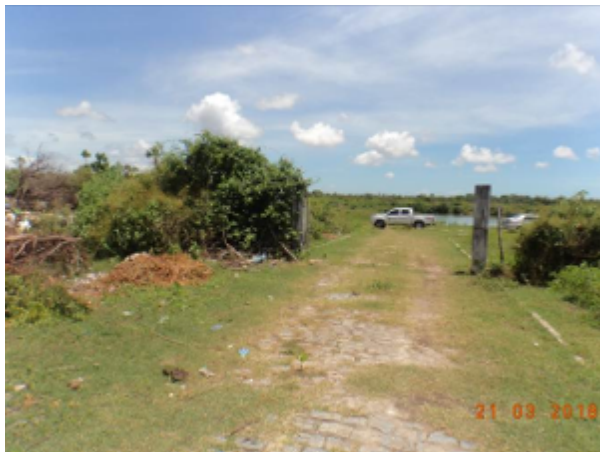
Foto 3 – ETE Choró: ausência de portão e de identificação para delimitação da área.
