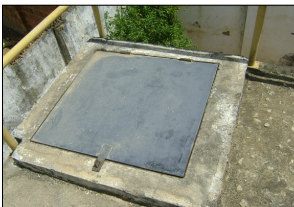
Foto 43 – RAP-01: Tampa de visita.
