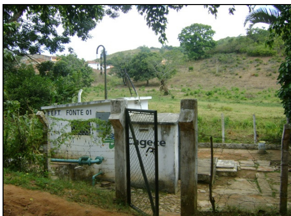
Foto 1 – FT-01: Existência de identificação e cerca de proteção.
