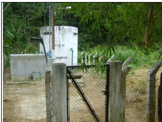
Foto 13 – PA-01: Existência de identificação e cerca de proteção.
