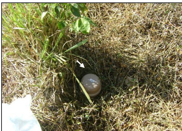
Foto 50 – Registro de descarga localizado na Rua Sebastião Monteiro.
