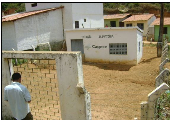
Foto 35 – EERD-01: Existência de identificação.
