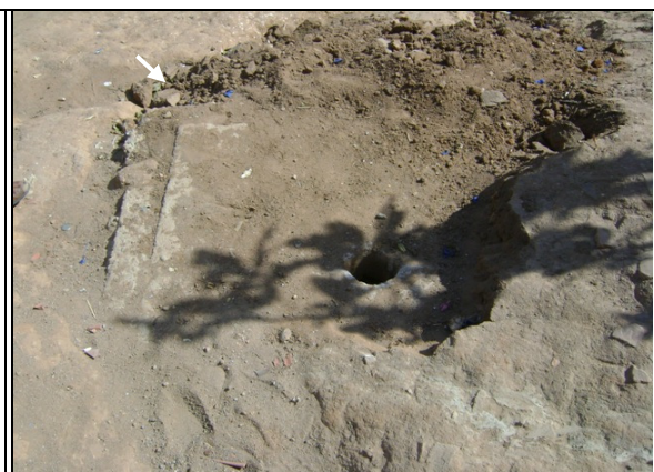
Foto 53 – Registro de descarga localizado na Rua SDO-04.
