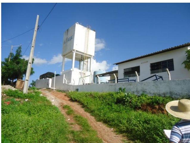
Foto 5 – Vista da entrada da ETA do SAA de Choró.
