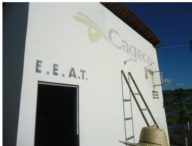
Foto 24 – Vista da EEAT-01.
