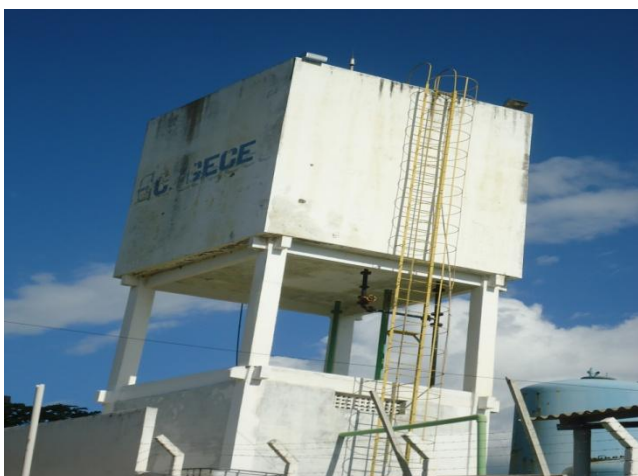
Foto 21 – Vista do REL-01.
