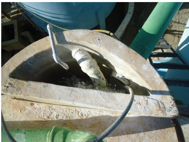
Foto 15 – Ausência de tampa na caixa de entrada de água do RAP-02.
