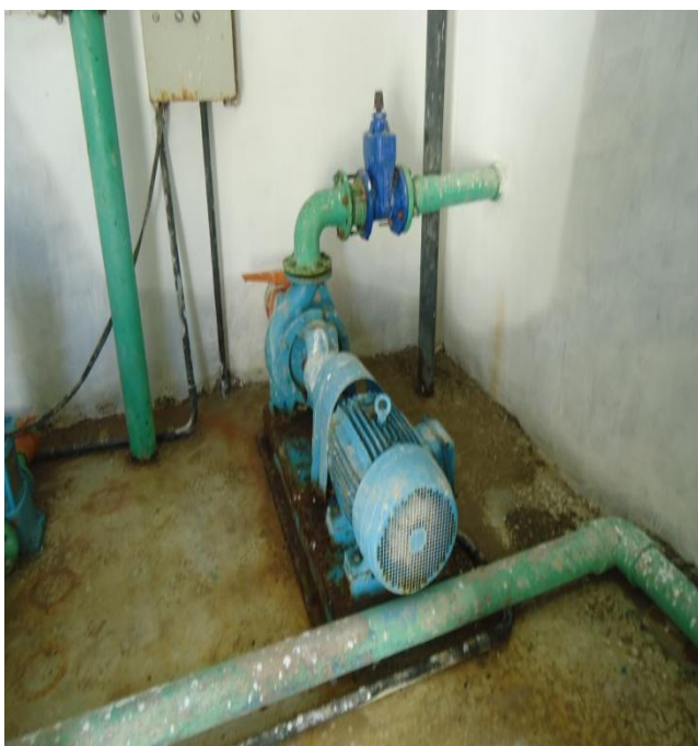
Foto 9 – Vazamento no registro do filtro de carvão ativado.
