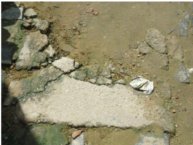
Foto 53 – Registro de descarga na rede soterrado – Rua José Edmilson Matos Pinto, 191.
