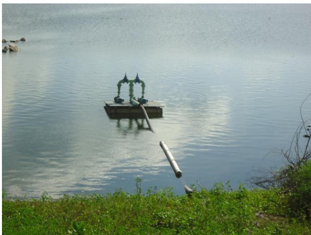
Foto 1 – Vista do flutuante - Açude Pompeu Sobrinho.
