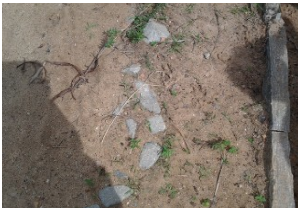
Foto 47 – Tapera: RDA registro de descarga soterrado na Rua Luíza Bento de Araújo, SMS 188.
