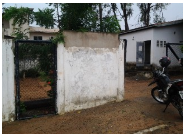
Foto 69 - Sede: EEE-04 - falta identificação
