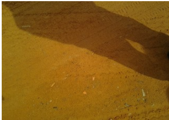
Foto 48 - Tapera: Registro de descarga soterrado na Rua Horácio Leite de Freitas (final).
