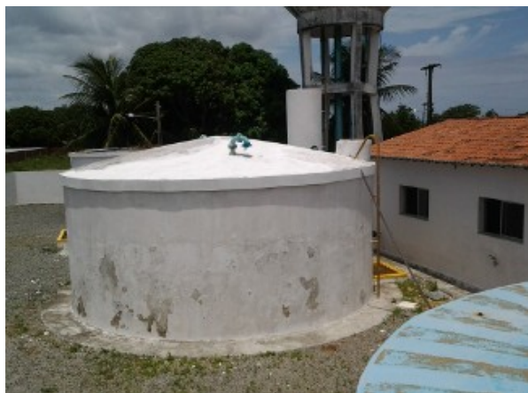
Foto 57 – Sede: RAP-01- sem identificação.
