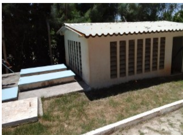
Foto 71 - Tapera/Riviera: EEE-01 - falta identificação.
