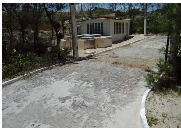
Foto 35 - Tapera/ Riviera: EEE-02 sem identificação e telhado sendo levantado pelo vento.
