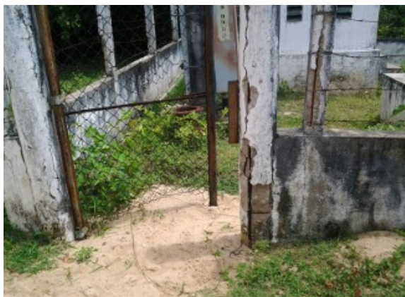
Foto 7 – Sede: captação está com portão e cerca danificados.
