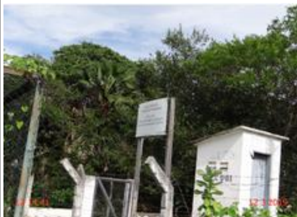
Foto 11- EEPR-01 (Sede): identificação incorreta (EECS-01) e a estrutura e a cerca da casa de abrigo estão deterioradas
