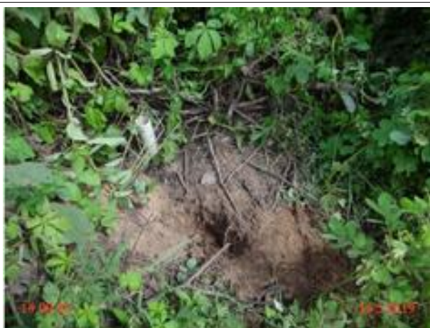
Foto 19 – RDA (Sede): registro de descarga soterrada na Estrada para Canaçu, s/n.
