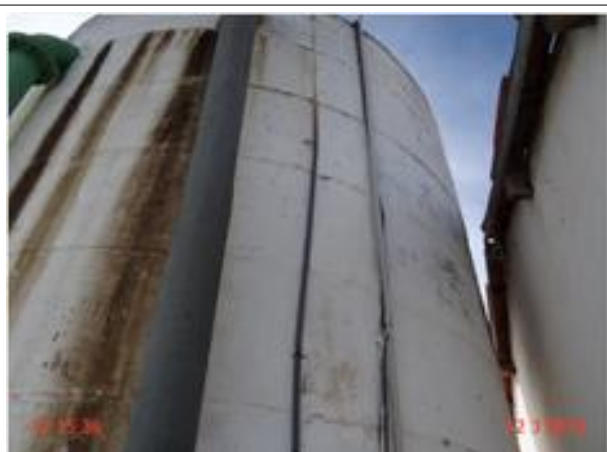
Foto 29 - RAP-04 (Sede): medidor de nível sem visibilidade.
