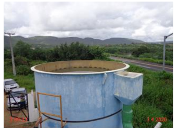
Foto 2 – F-01: ausência de tampa.
