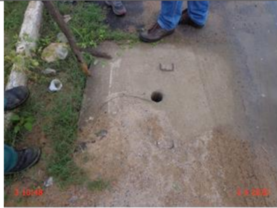
Foto 16 – RDA: registro de descarga soterrado, localizado na Rua Tonico Nunes.
