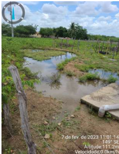
Foto 18 - RAP-02/EERD área alagada devido ao extravasamento do reservatório.
