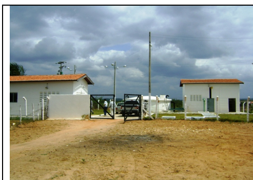
Foto 4 – Vista da entrada da ETA do SAA de Potiretama
