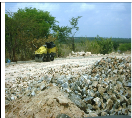
Foto 42 – Obras na via de acesso ao Sítio Trapiá - II
