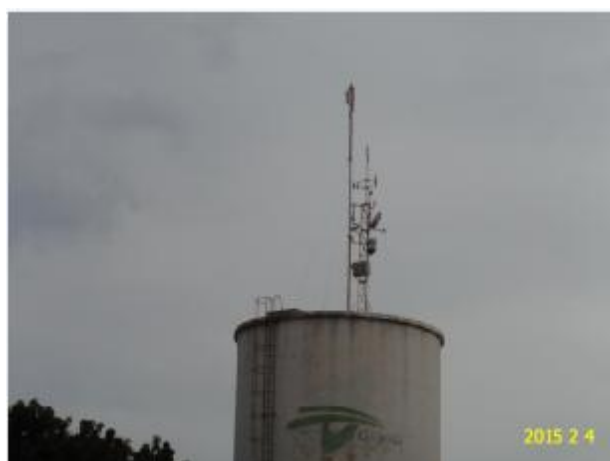
Foto 5 – REL-01: ausência de guarda-corpos na laje de cobertura.
