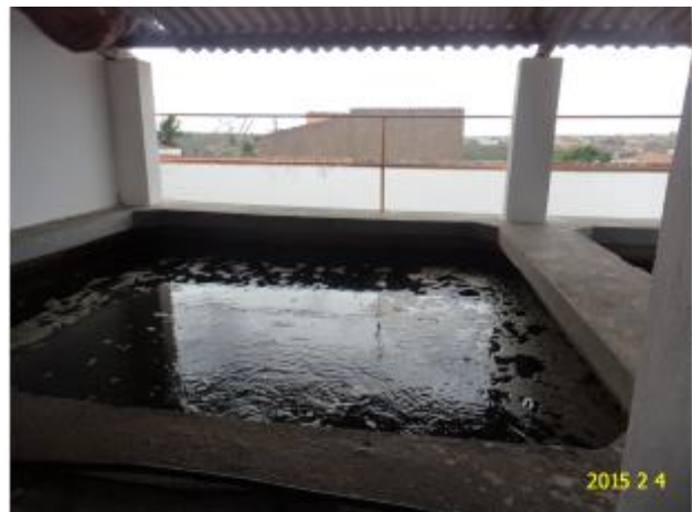
Foto 8 – Filtro-01: presença de bolhas na superfície.
