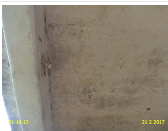
Foto 4- PT-02: ausência de iluminação.
