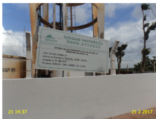
Foto 25 - ETA: placa com a data de validade vencida desde agosto/2016.
