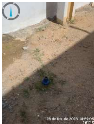
Foto 56 EEAT-08 + RAP-06: RAP-06 com registro enterrados.
