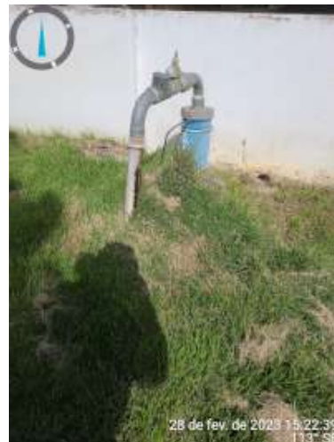
Foto 16 PT-12: Sem identificação.
