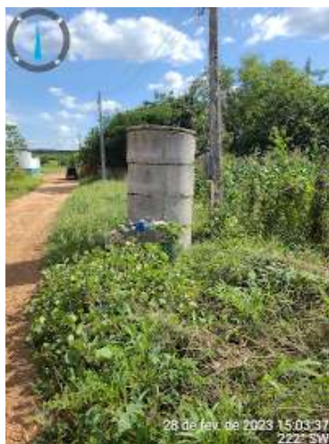
Foto 1 PT-06: sem identificação e ausência de delimitação da área.
