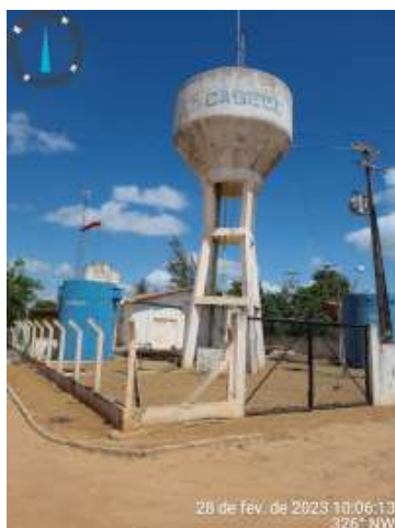
Foto 76 ETA + REL-01 + RAP-01: REL-01 com pintura desgastada, vazamento na caixa de registro de saída; RAP-01 com pintura desgastada.
