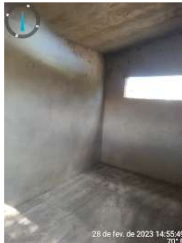
Foto 53 EEAT-08 + RAP-06: EEAT-08 em construção.
