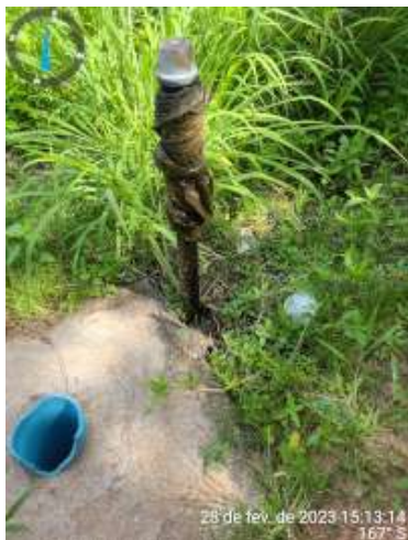
Foto 15 PT-Não identificado: sem identificação e sem tamponamento adequado.
