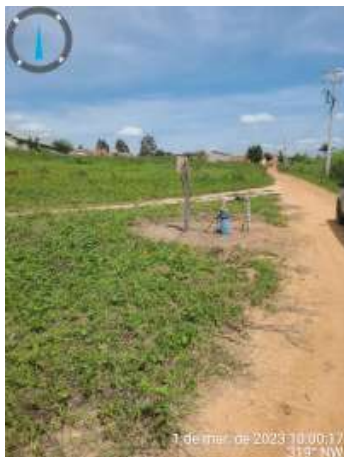
Foto 33 PT-13 (Desativado): Localizado entre bifurcação de ruas, sem delimitação de área, sem identificação.
