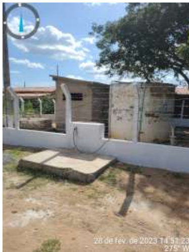
Foto 52 EEAT-08 + RAP-06: infraestrutura em obras de manutenção e recuperação.
