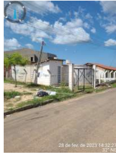
Foto 51 EEAT-06 + RAP-02 + RAP-03: Infraestrutura necessitando de limpeza, reparos, manutenção e pintura.
