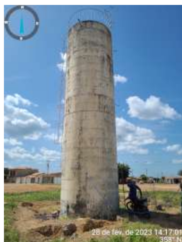
Foto 42 REL-03 (desativado) + By pass: Infraestrutura em processo de recuperação e manutenção.
