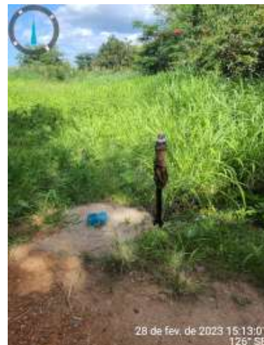
Foto 14 PT-Não identificado: Instalação desativada e localizada na margem da rua, com ausência de delimitação e proteção da área.
