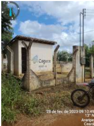
Foto 3 EEAT-07: sem iluminação externa.
