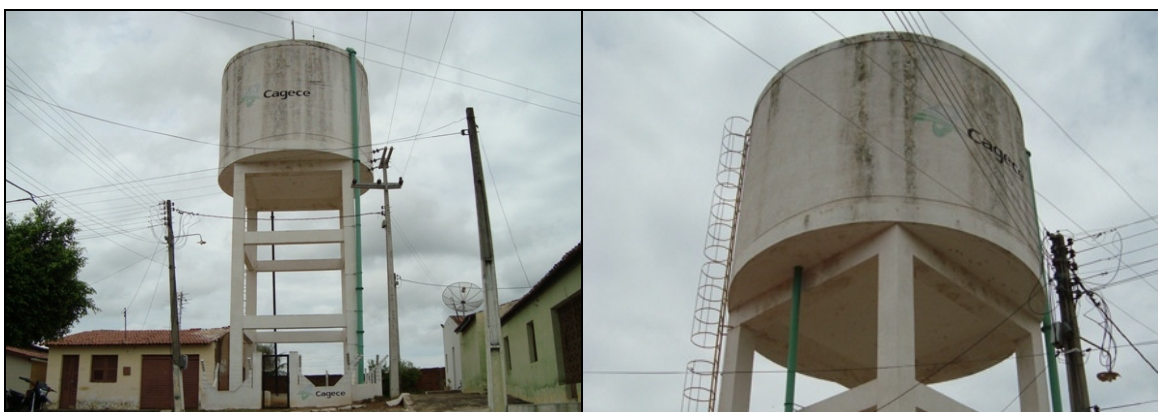
Fotos 28 e 29 – Vistas do REL-01.
