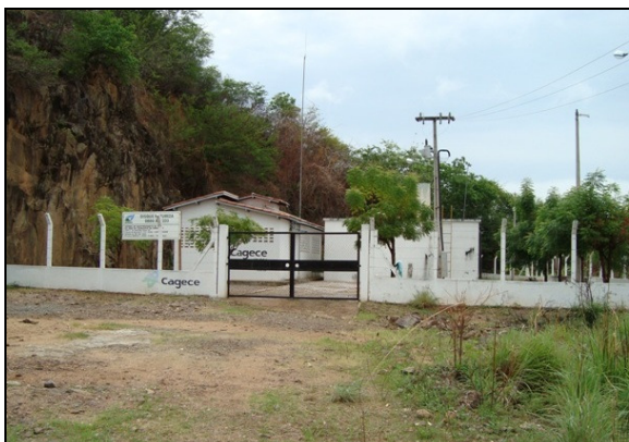
Foto 3 – Entrada da ETA.
