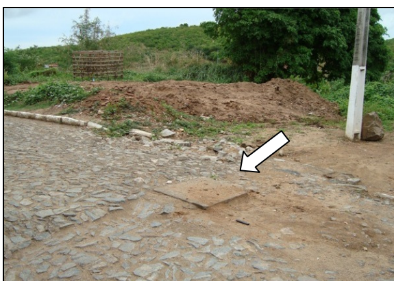
Foto 32 – Registro de descarga na Rua Raul Nogueira, Esplanada.
