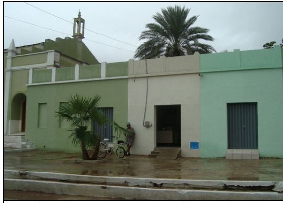
Foto 36 – Vista externa do escritório da CAGECE.
