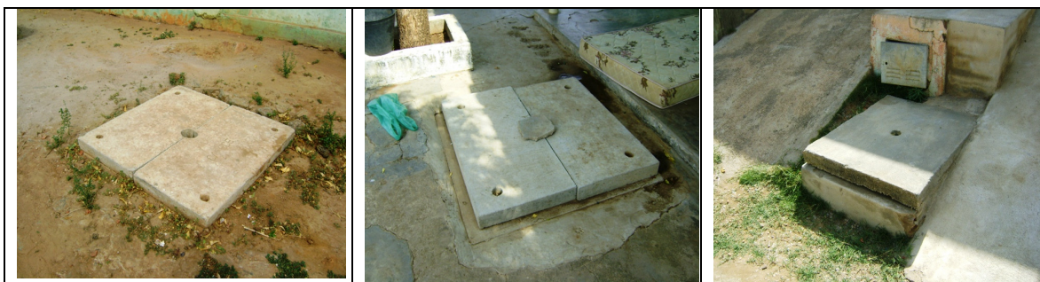
Fotos 44, 45 e 46 – Registros de descarga nas Ruas João Batista de Almeida, José Maria Bessa e São José
