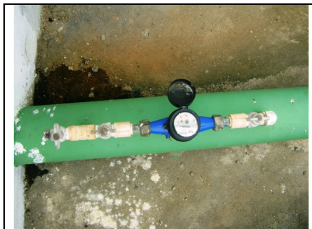
Foto 40 – Medidor proporcional na saída do RAP-1 para o REL-01
