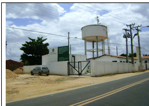
Foto 5 – Vista da entrada da ETA do SAA de Iracema
