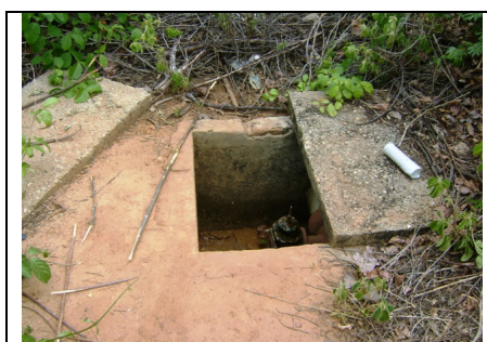
Foto 39 – Caixa de proteção na adutora de água bruta
