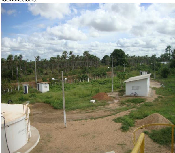
Foto 9 – Vista dos PTs com fácil acesso e iluminação para trabalhos noturnos.
