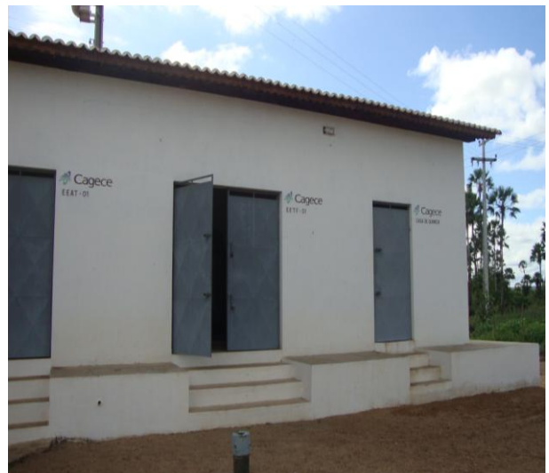
Foto 48 – Vista externa da casa das estações elevatórias EAT-01 e EETF-01.
