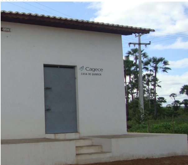
Foto 27 – Vista externa da casa de química.
