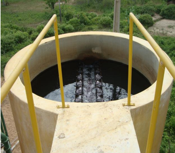
Foto 21 – ETA: Filtro ascendente sem lajem de cobertura.
