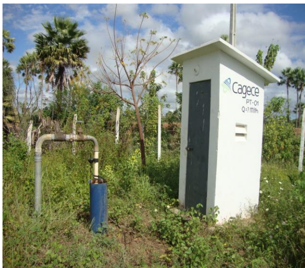
Foto 1 – Vista do PT-01 desativado.
