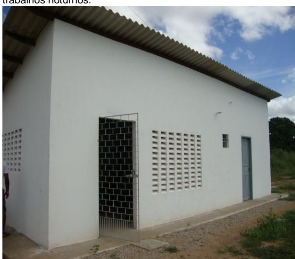
Foto 11 – Vista frontal da casa de apoio operacional.
