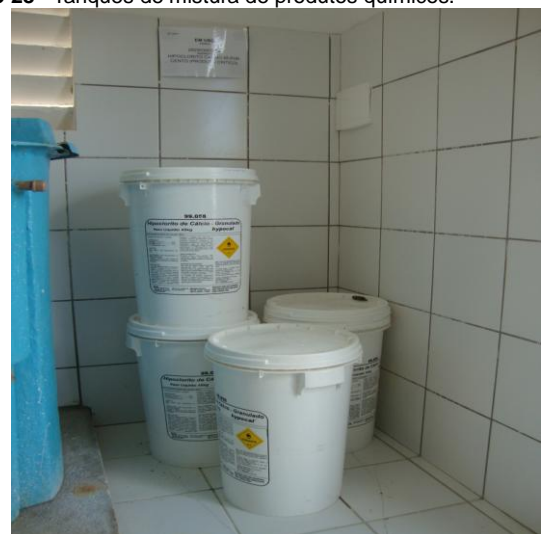
Foto 30 – Armazenamento de hipoclorito de cálcio em uso, com data de fabricação em março de 2013.
