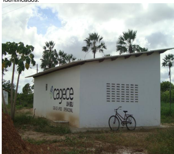
Foto 10 – Vista lateral da casa de apoio operacional.
