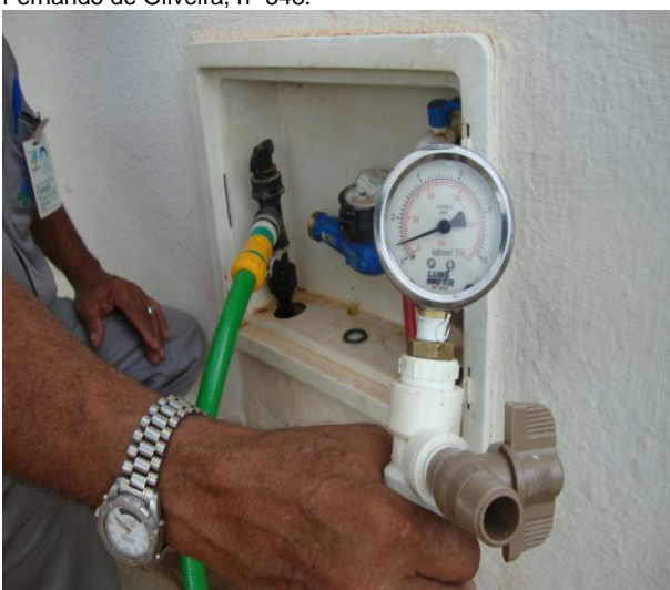
Foto 71 – Medição de pressão instantânea na Rua Marcondes Rodrigues, nº 444.
