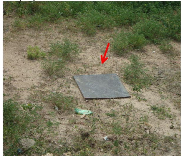
Foto 46 – Adutora de água tratada, localizada próxima a ETA.
