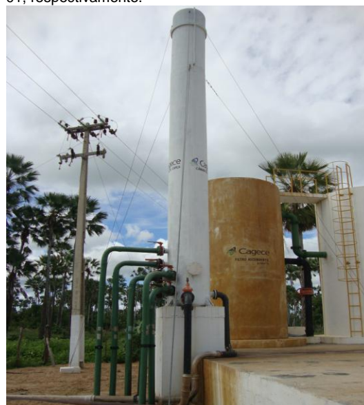
Foto 54 – Torre de equilíbrio.
