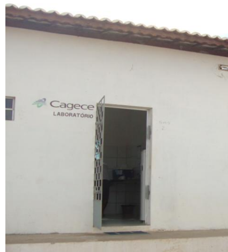
Foto 36 – Vista externa do laboratório.
