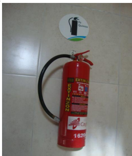
Foto 88 – Extintor de incêndio da loja de atendimento dentro do prazo de validade e disposto em local adequado.
