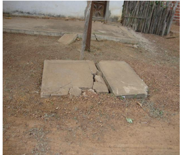
Foto 74 – Registro de descarga na Rua Manoel Cunha, nº 1.543.
