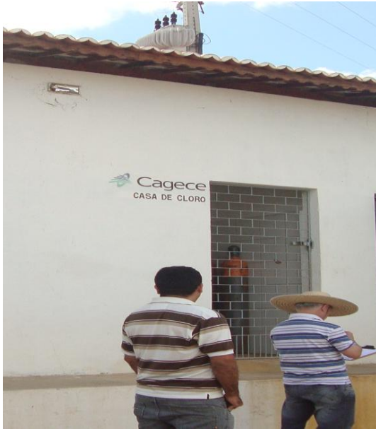
Foto 31 – Vista externa da Casa de cloro.
