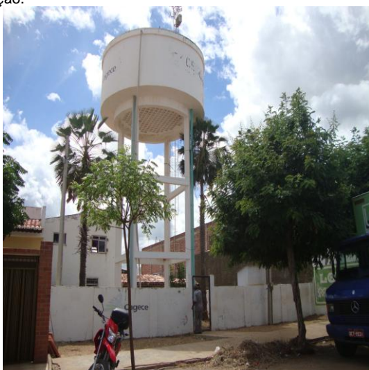
Foto 59 – Vista do REL-01.
