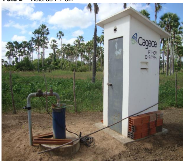
Foto 4 – Vista do PT-04 desativado.
