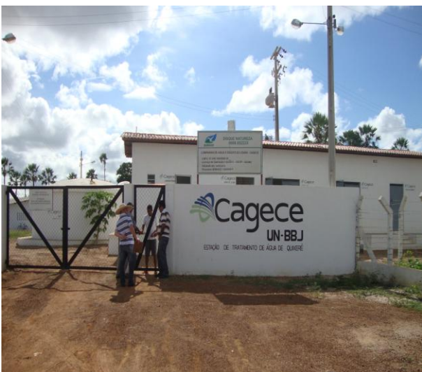
Foto 17 – Vista externa da ETA.
