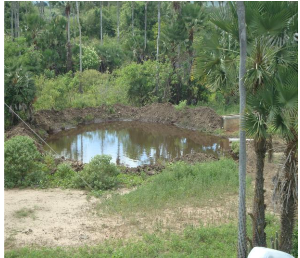
Foto 26 – Disposição das águas de lavagem dos filtros lançadas em um terreno nas proximidades da ETA.
