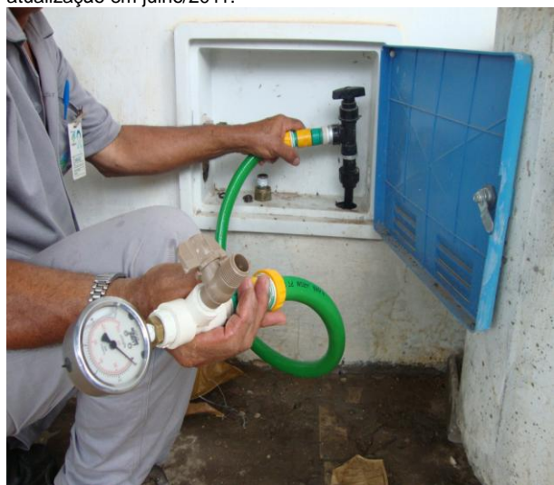
Foto 66 – Medição de pressão instantânea na Rua Pe. Zacarias, nº 471, Centro.
