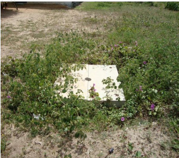
Foto 75 – Registro de descarga na Rua João Alves Carneiro.
