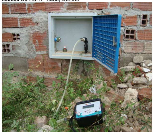
Foto 72 – Medição de pressão com instalação às 15:00h do dia 5/06/13 e retirada às 15:00h do dia 6/06/13, com aparelho datalogger na Rua Afonso José da Silva, nº 21, Nova Morada.
