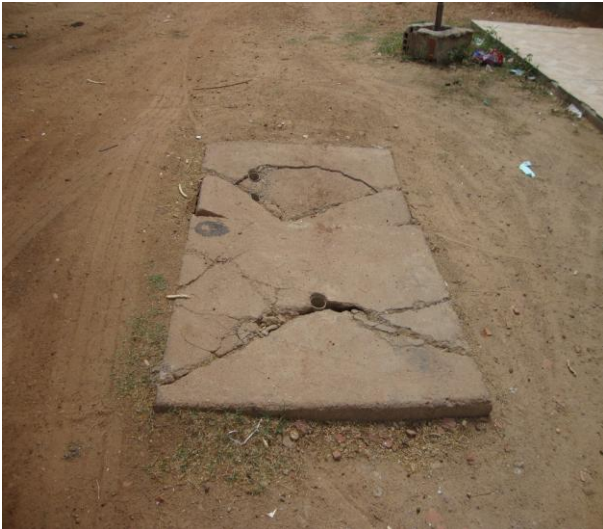
Foto 73 – Registro de descarga na Rua Manoel Cunha, nº 9.156.
