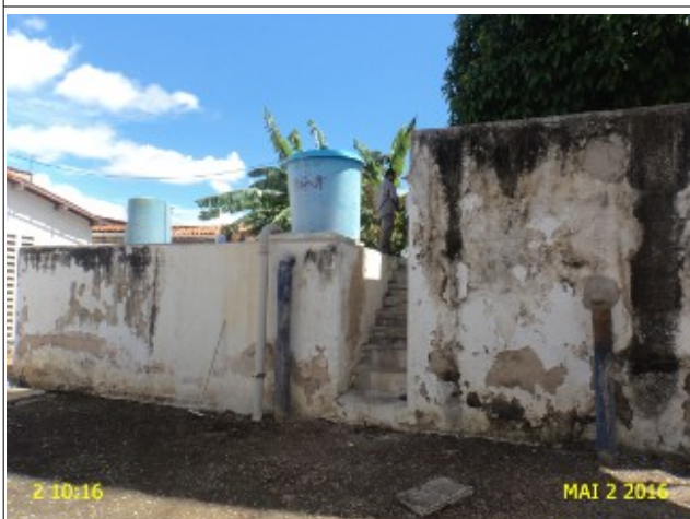
Foto 22 – RAP-02 (Triângulo); apresenta pintura e reboco deteriorado e sem identificação.
