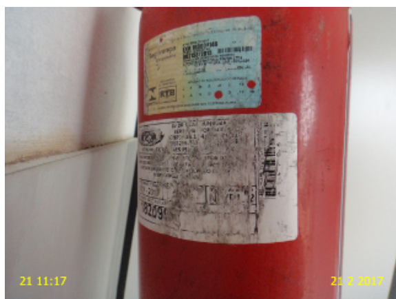
Foto 22 - Almojarifado/escritório (Sítio Alegre): etiqueta com data de validade da recarga e do teste do cilindro com pouca visibilidade.
