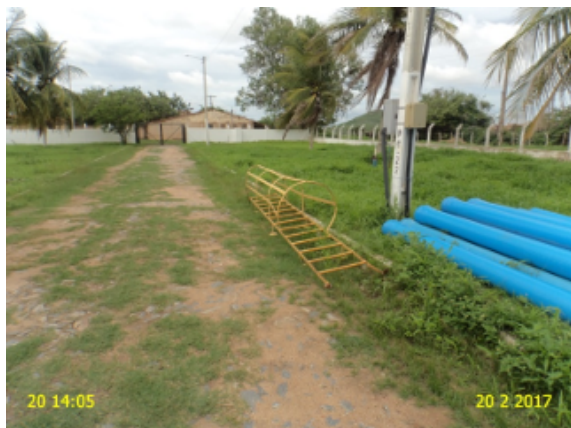
Foto 26 - ETA (Sede): escada de acesso aos filtros F-01 e F-02 com defeito.
