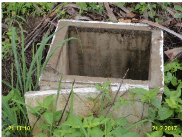
Foto 28 - Registro de descarga com a tampa retirada localizado na Av. São Francisco (Sítio Alegre).
