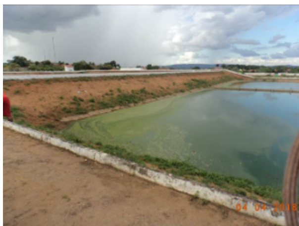
Foto 6 – ETE (Sede): acúmulo de sobre-nadantes na lagoa de maturação LM(2).
