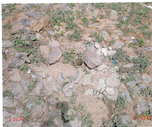
Foto 24 – RDA: registro de descarga, localizado no endereço Sítio Acarape, sem caixa de proteção.
