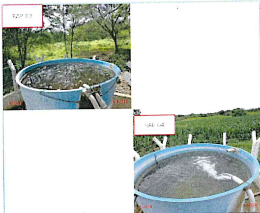
Foto 19 – Reservatórios: RAP-03 e RAP-04 com ausência de tampa e de identificação.
