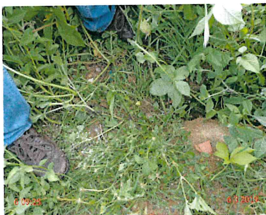
Foto 23 – RDA: excesso de vegetação na área do registro de descarga, localizado no endereço Rua Abdias.
