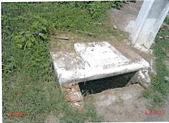
Foto 25 – RDA: construção de um bueiro em cima do registro de descarga, localizado na Rua Professora Maria do Socorro Noronha.
