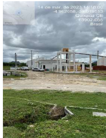
Foto 50 - Módulo da ETE (ETE Herval): encontra-se inoperante.
