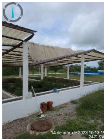
Foto 36 ETE Raquel de Queiroz: Leito de secagem (vegetação em crescimento e cobertura deteriorada).
