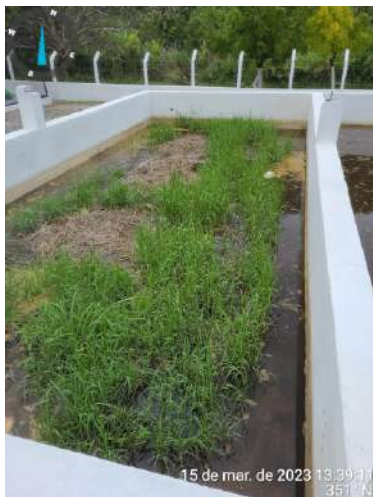
Foto 29 - Leito de secagem (Juatama): acúmulo de vegetação.
