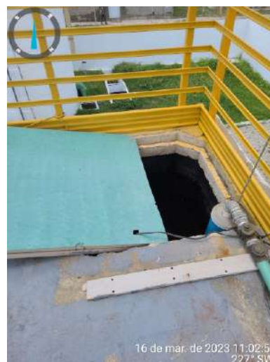
Foto 22 - RAP-05 (Sede): tampa aberta.
