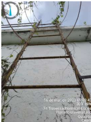
Foto 13 - RAP-02 (Sede): escada corroida e com vegetação,, guarda-corpo oxidado e sem estabilidade.
