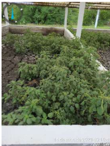
Foto 35 - ETE Raquel de Queiroz: Leito de secagem (vegetação em crescimento e cobertura deteriorada).
