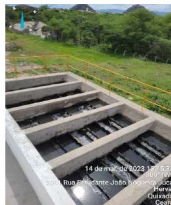
Foto 44 - ETE Herval - Caminho preferencial da passagem do efluente no decantador.
