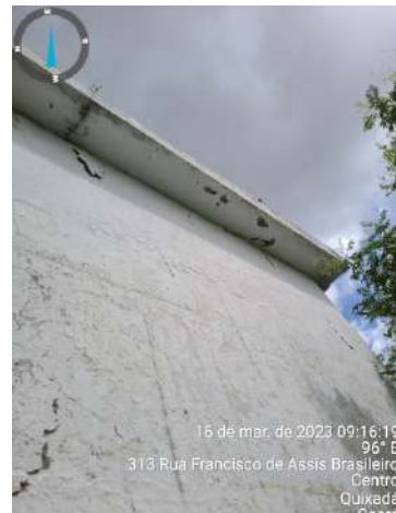
Foto 14 - RAP-02 (Sede): estrutura em concreto armado com aço exposto.
