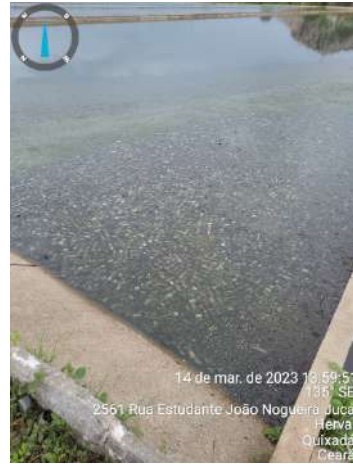
Foto 48 - Lagoa de maturação (ETE Herval): presença de meio suporte do leito filtrante.
