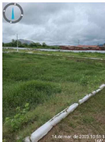
Foto 38 - ETE Campo Novo: Lagoa Anaeróbia fora de operação.
