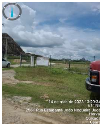
Foto 43 - ETE Herval - Placa da entrada apagada.
