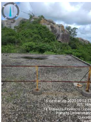
Foto 15 - RAP-02(Sede): acúmulo de água pluvial na laje, guarda-corpo oxidado e sem estabilidade.
