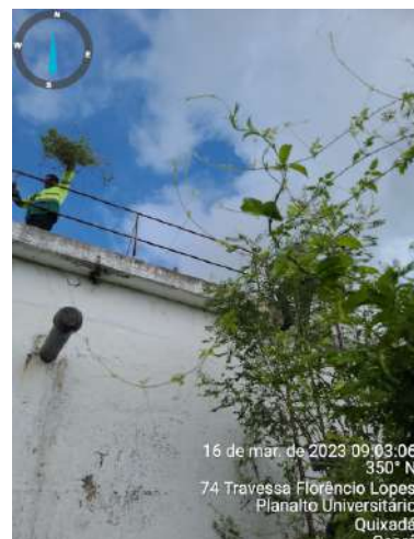
Foto 16 - RAP-02 (Sede): guarda-corpo oxidado e sem estabilidade.
