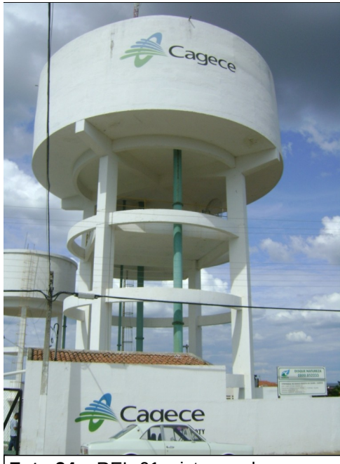
Foto 24 - REL-01: vista geral
