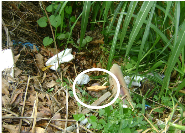
Foto 37 – Registro de descarga sem caixa na Francisco Sá, aos fundos do Teatro Municipal .
