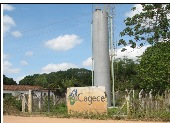
Foto 90 – Tanque de amortecimento unidirecional desativado.
