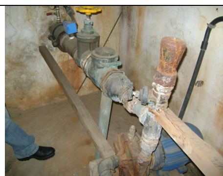
Foto 53 – EERD-02: escoramento do barrilete improvisado com madeira.
