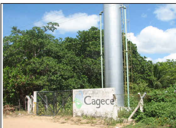
Foto 89 – Tanque de amortecimento unidirecional desativado.
