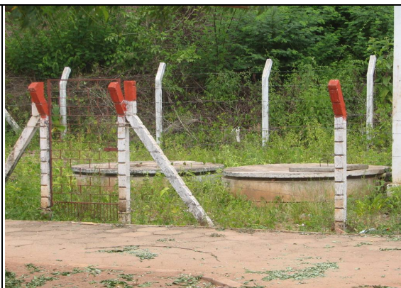
Foto 66 – RSE-04 e 05: ausência de limpeza da área de localização.
