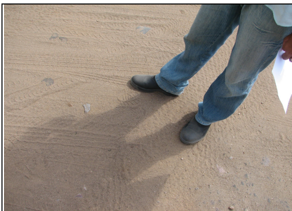
Foto 97 – Registro de descarga localizado na Travessa José de Alencar - Centro, em frente ao nº 57 (SMSA), encoberto com terra.
