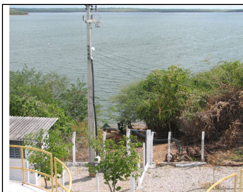
Foto 1 – Vista do Açude Aracoiaba e da tomada direta.
