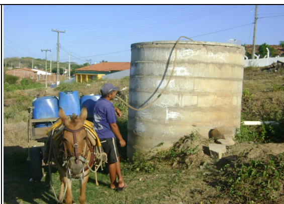
Foto 77 – RAP-04: abastecimento irregular, realizado por usuário não autorizado.
