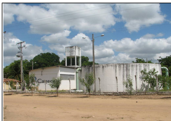
Foto 64 – RSE-02: ausência de identificação.
