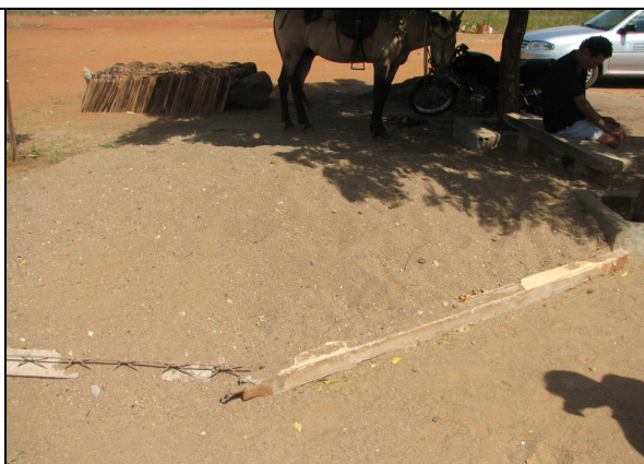
Foto 100 – Registro de descarga localizado na Praça da Estação – Centro, encoberto com terra.
