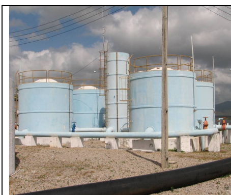
Foto 5 – Vista frontal dos filtros da ETA de Aracoiaba.
