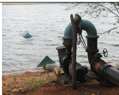
Foto 2 – Tomada direta com mangote flexível.
