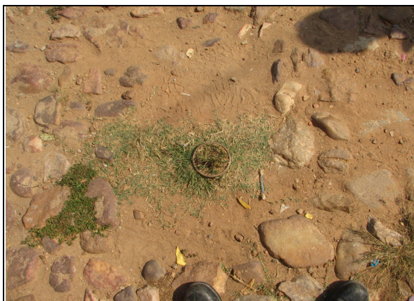
Foto 101 – Registro de descarga localizado na Rua João Paulo II – Centro, em frente ao nº 226.
