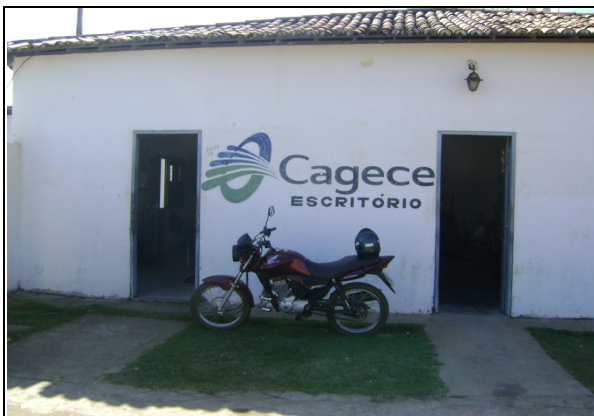
Foto 103 – Vista externa do escritório/loja de atendimento/almoxarifado.
