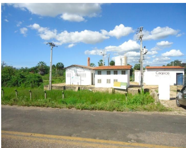
Foto 5 – Entrada da ETA.
