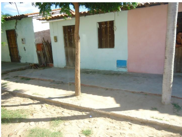
Foto 54 – Registro de descarga na rede soterrado – Rua Davi Barros.
