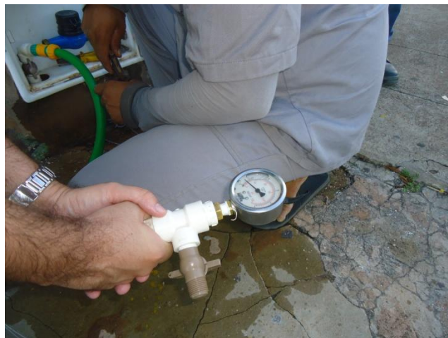
Foto 59 – Medição de pressão instantânea – Praça da Igreja Matriz – Centro.
