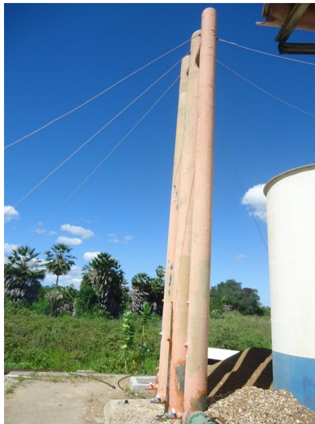
Foto 8 – Torre de equilíbrio.
