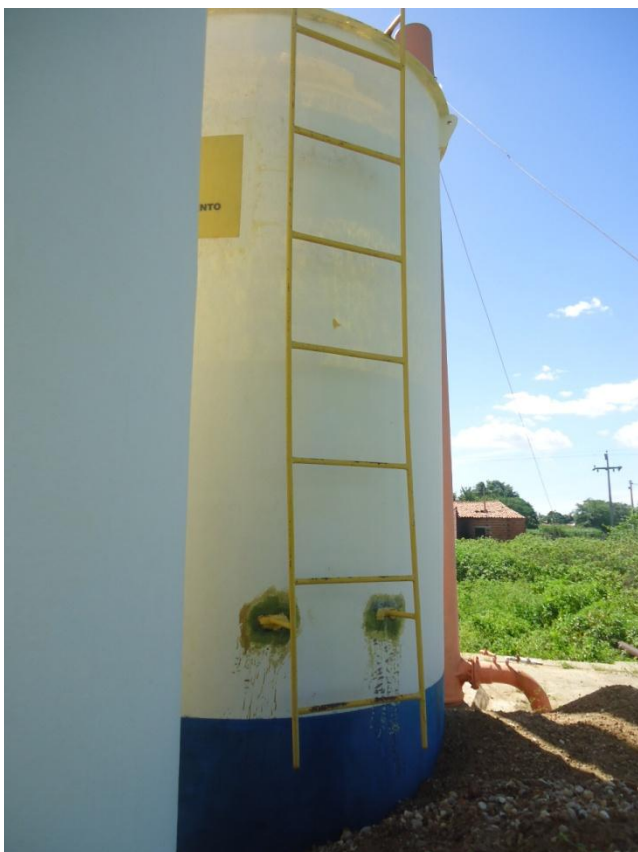
Foto 11 – Escada de acesso F-01.
