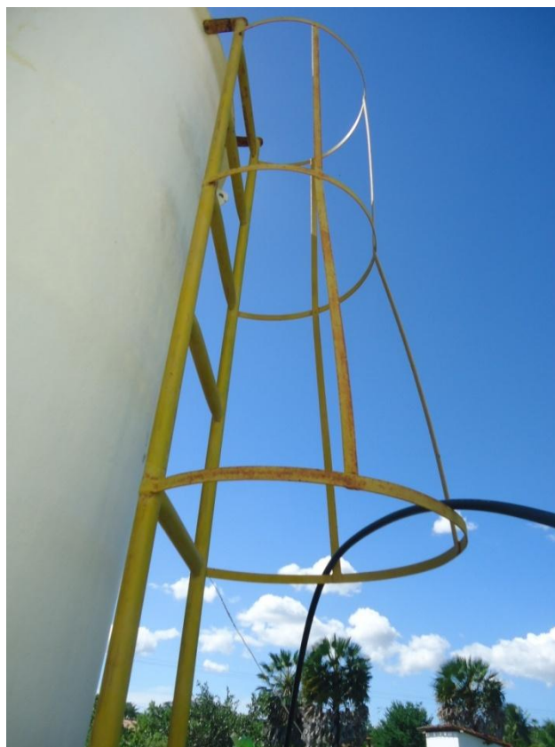
Foto 12 – Escada de acesso F-02.
