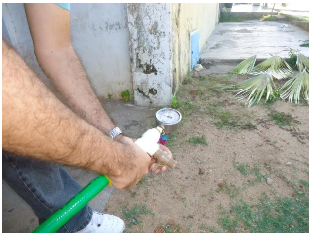
Foto 58 – Medição de pressão instantânea – Rua Luis Gomes Diniz, 319 – São Francisco.
