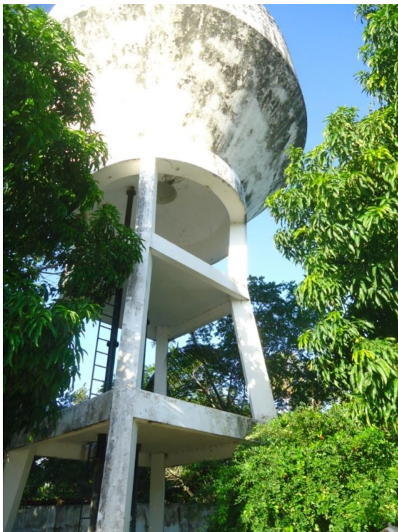
Foto 48 – Vista lateral do REL-01.
