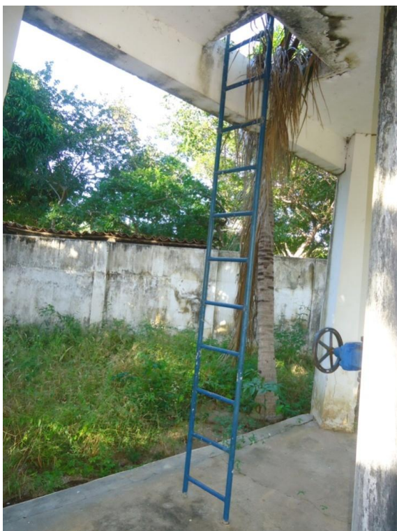
Foto 50 – Escada de acesso REL-01.
