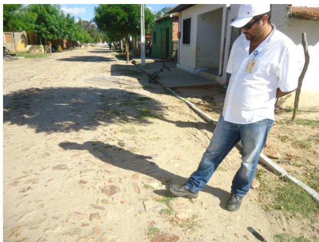
Foto 55 – Registro de descarga na rede soterrado – Rua Francisco Torres.
