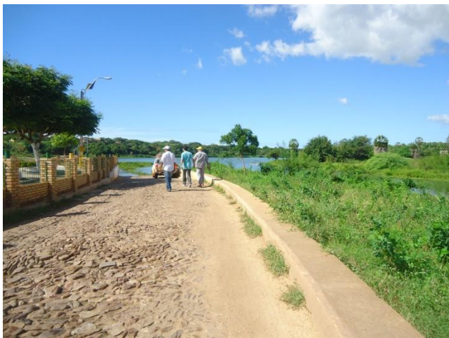
Foto 1 – Acesso à captação.
