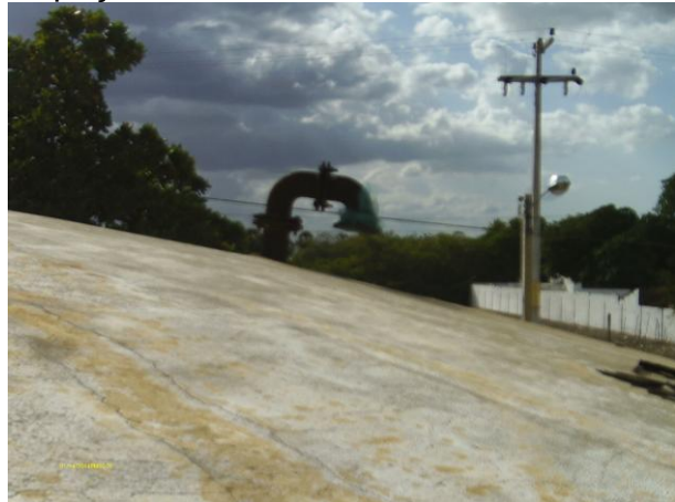
Foto 39 - RAP-01: tubulação de ventilação.
