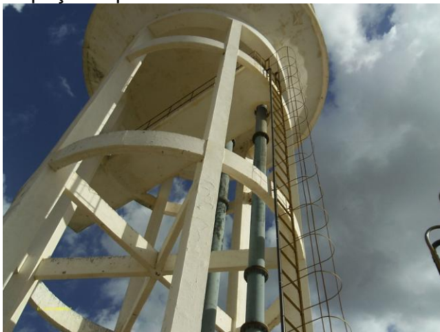
Foto 44 - REL-01: escada de acesso.
