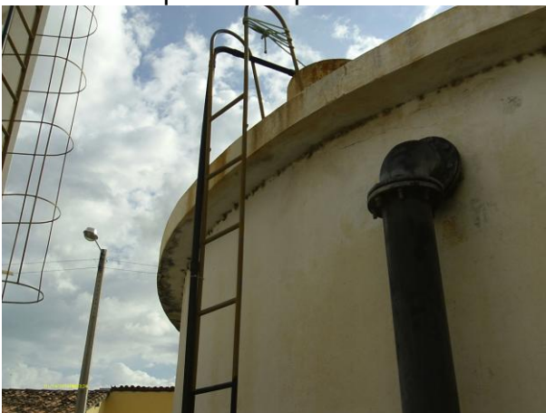
Foto 40 - RAP-01: escada de acesso e tubo extravasor.
