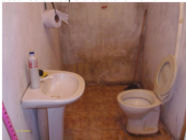
Foto 68 - Escritório: instalações sanitárias.
