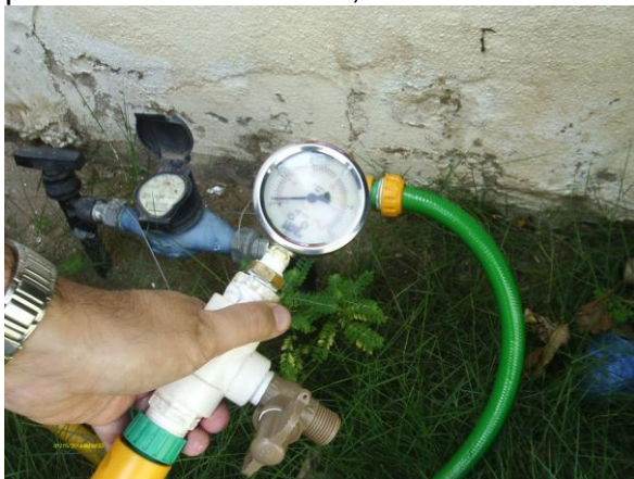
Foto 51 - Medição instantânea de pressão: Rua Pe Rocha, 1543.
