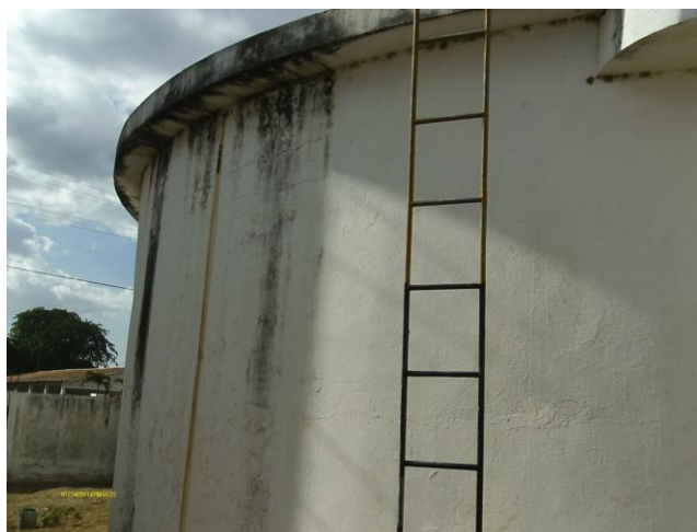
Foto 13 - F-03: escada de acesso.
