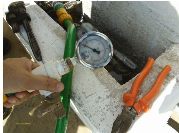
Foto 50 - Medição instantânea de pressão: Rua Antonio Rocha Freitas, 1550.
