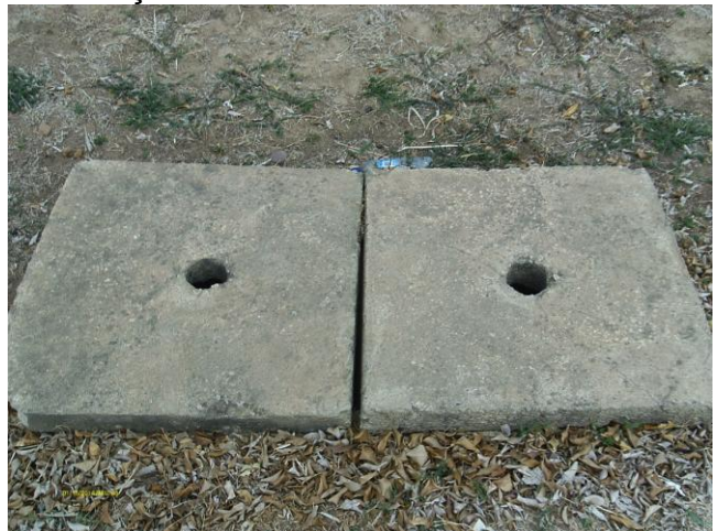
Foto 62 - Registro de descarga na rede de distribuição: Av. José de Almeida.
