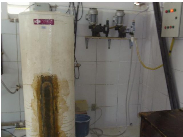
Foto 18 - Casa de química: tanque dosador de flúor.
