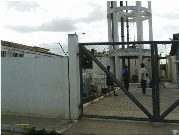
Foto 6 - ETA: ausência de placa indicativa que a área pertence à CAGECE.
