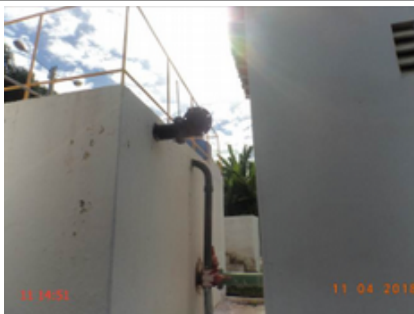
Foto 19 – RAP-01 (Sede): tubulação do extravasor inadequada.
