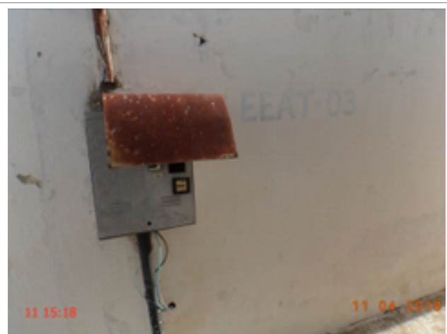
Foto 23 – EEAT-03 (Sede): identificação pouco visível.
