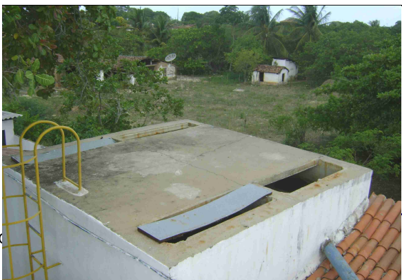
Foto 4 – Vista dos filtros de concreto 01 e 02.
