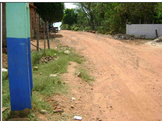
Foto 25 – Registro de descarga localizado na Rua São Luís Monteiro – registro soterrado.
