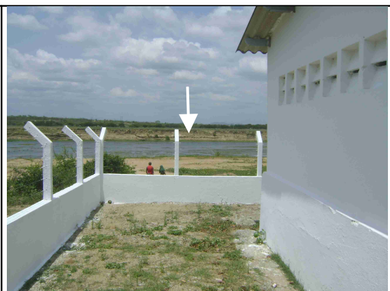
Foto 2 – Rio Curu, ponto onde estão instalados os drenos
