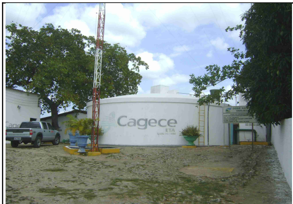
Foto 3 – ETA do SAA de São Luís do Curu.
