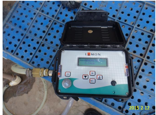
Foto 12 – Medição de pressão na Rua da Paz nº 611.
