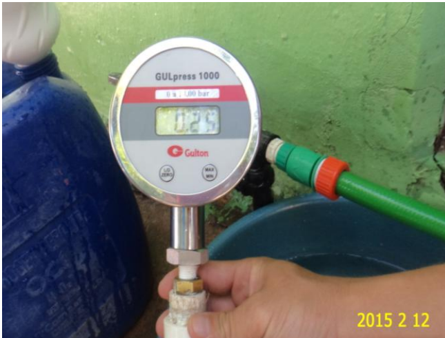
Foto 11 – Medição de pressão na Rua da Amizade (LT 192).
