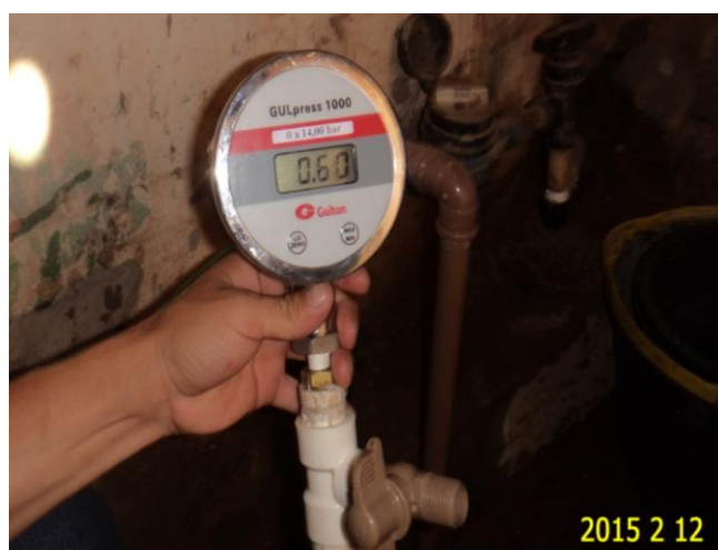
Foto 10 – Medição de pressão na Rua da Esperança, s/n (sms 486).
