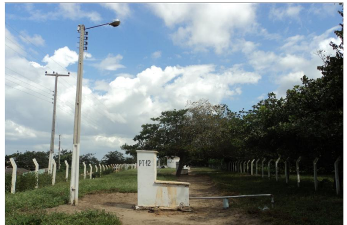
Foto 2 – PT-12: área do poço com identificação e iluminação noturna.
