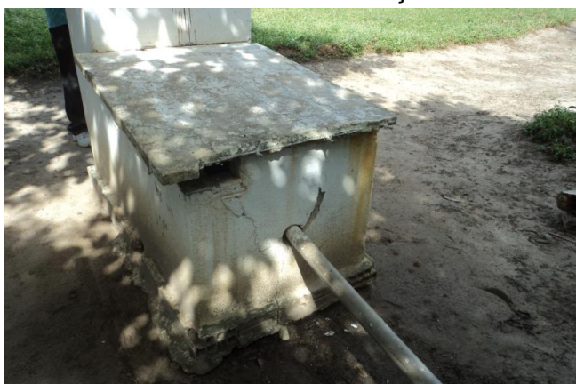
Foto 22 – PT-16: estrutura da casa de abrigo.
