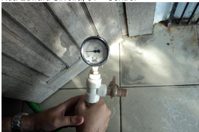
Foto 84 – Medição instantânea de pressão na Av. Alcides Rocha, 473 – São Luiz.
