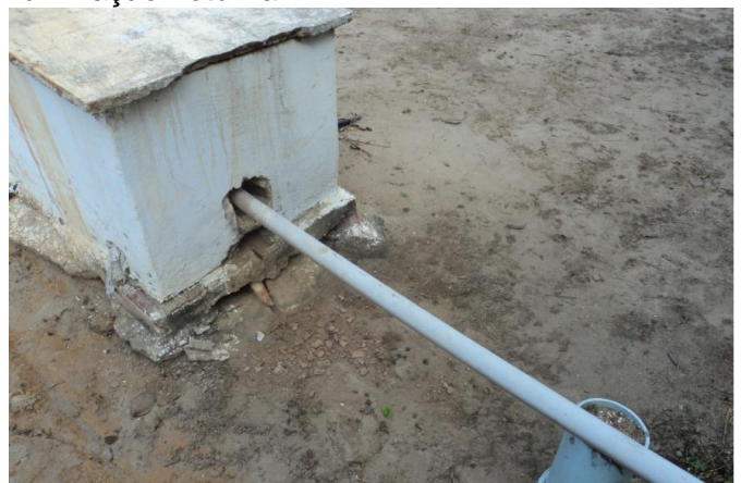
Foto 4 – PT-12: estrutura da casa de abrigo do QC.
