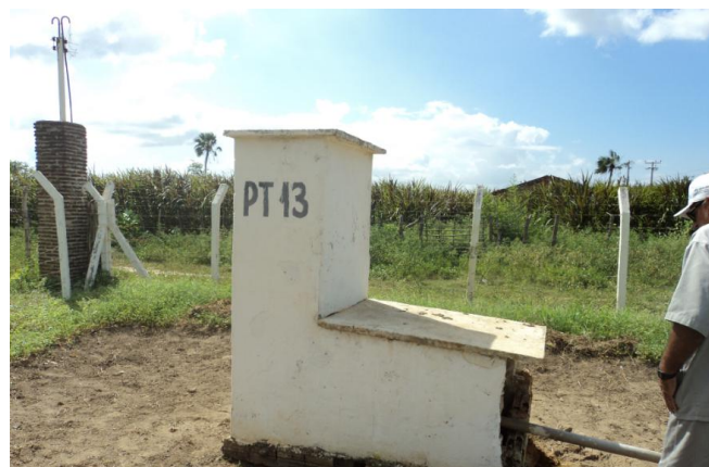
Foto 6 – PT-13: área do poço e identificação.
