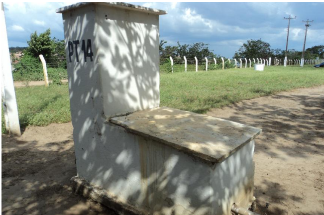
Foto 13 – PT-14: casa de abrigo do QC.
