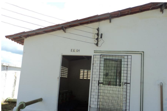
Foto 63 – EE-01: área de acesso e identificação.
