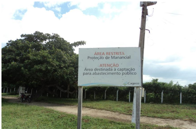
Foto 1 – PT-01: área de proteção de manancial com placa de identificação.
