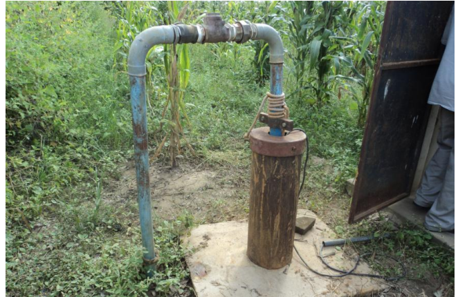
Foto 30 – PT-18: laje de proteção.
