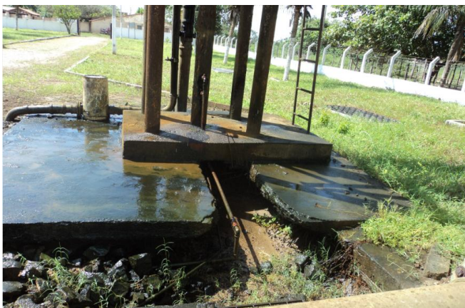
Foto 37 – Aerador: estrutura inferior.
