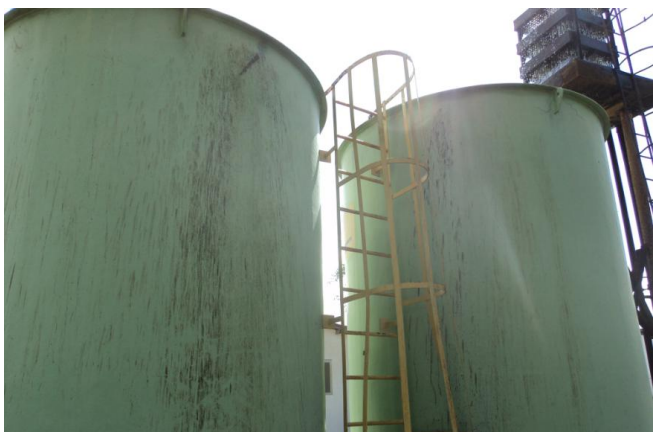
Foto 45 – Filtros: escada de acesso
