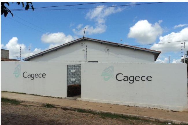
Foto 88 – Loja de atendimento: vista externa.
