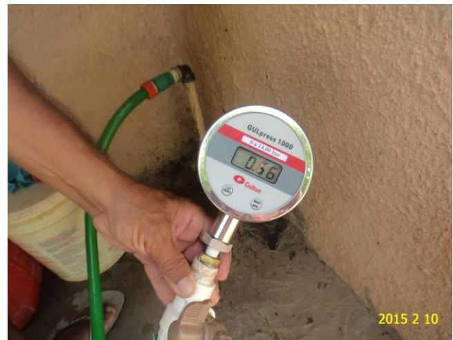
Foto 28 – Medição de pressão na Rua Domingos de Mato, nº 10 – Centro.
