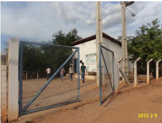
Foto 6 – EEAB-01: sem identificação.
