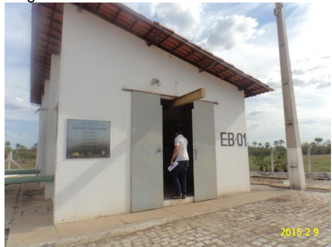
Foto 7 – EELF-01 e EEAT-05: identificação incorreta.
