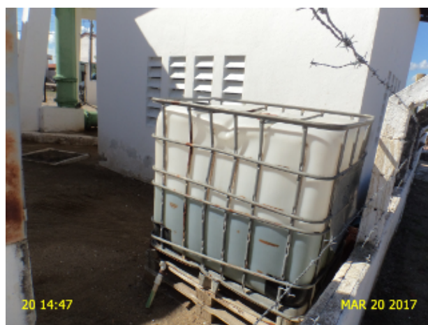
Foto 6 – ETA: produto químico armazenado inadequadamente.
