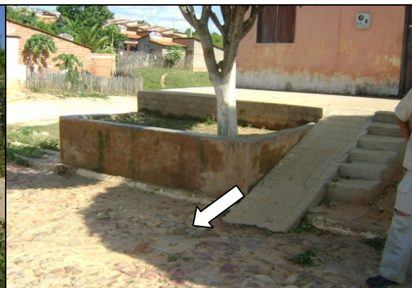
Foto 51 – Registro de descarga localizado na Rua João Francelino Ribeiro, Mutirão.
