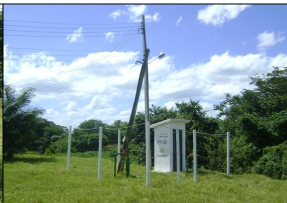
Foto 17 – Prédio de abrigo do quadro de comando da EEPT-02.
