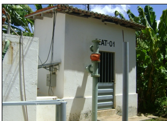
Foto 33 – Prédio de abrigo da EEAT-01.
