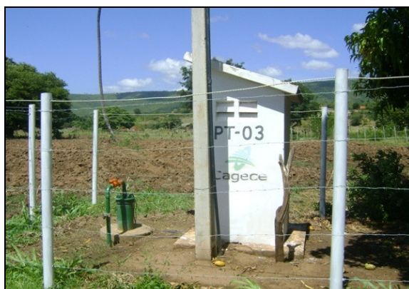
Foto 20 – Prédio de abrigo do quadro de comando da EEPT-03.
