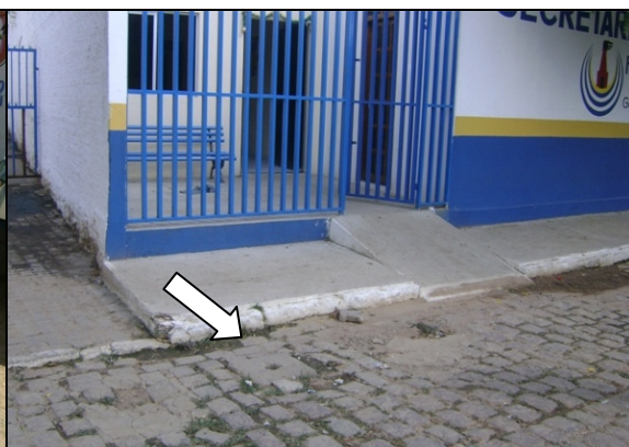
Foto 53 – Registro de descarga localizado na Rua Manoel Pinheiro de Almeida, Centro.
