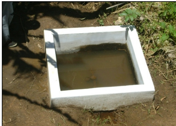
Foto 46 – Medidor proporcional de água bruta na entrada da ETA.
