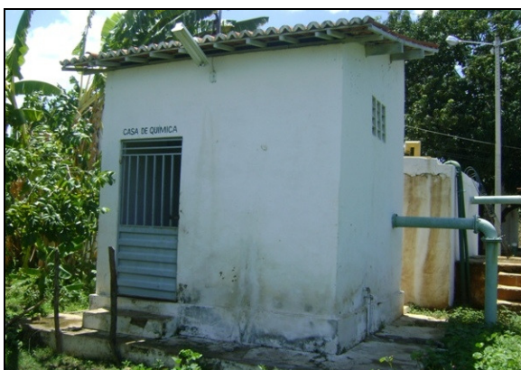
Foto 4 – Vista da casa de química.
