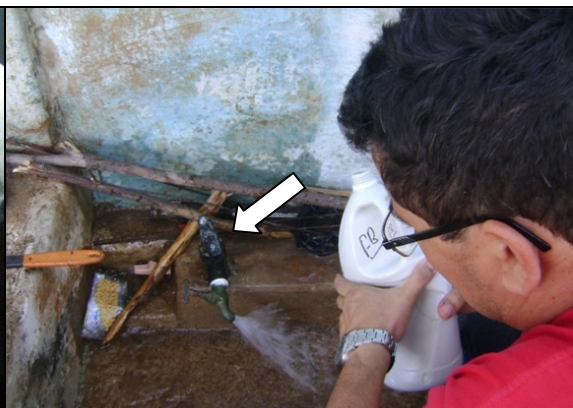
Foto 61 – Medição de pressão na Rua Benjamim José Leite, 142 – Nova Esperança, antes do hidrômetro.
