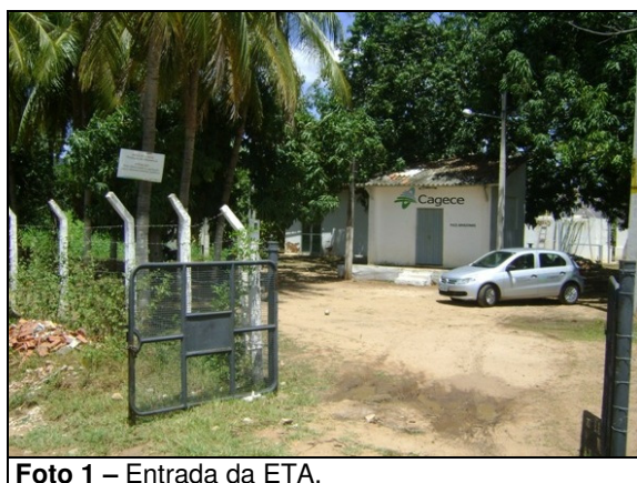
Foto 1 – Entrada da ETA.
