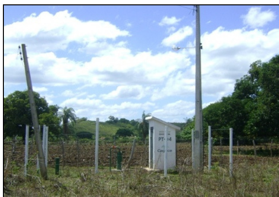
Foto 23 – Prédio de abrigo do quadro de comando da EEPT-04.
