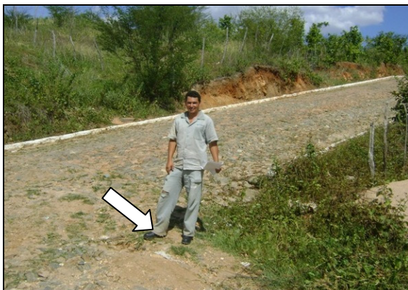
Foto 50 – Registro de descarga localizado na Rua Maria Aurineide Pinheiro, Boa Vista.
