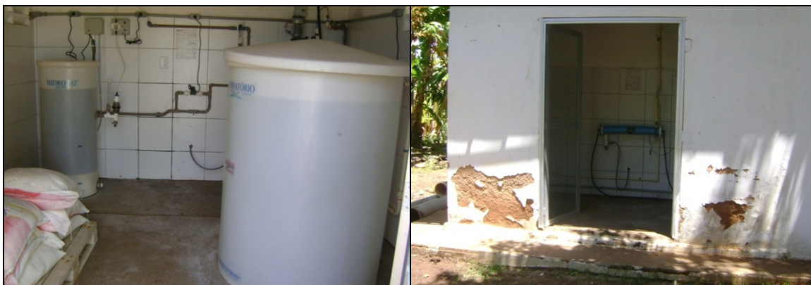
Fotos 6 e 7 – Vistas da fábrica de cloro.
