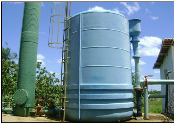
Foto 2 – Vista do filtro 01.
