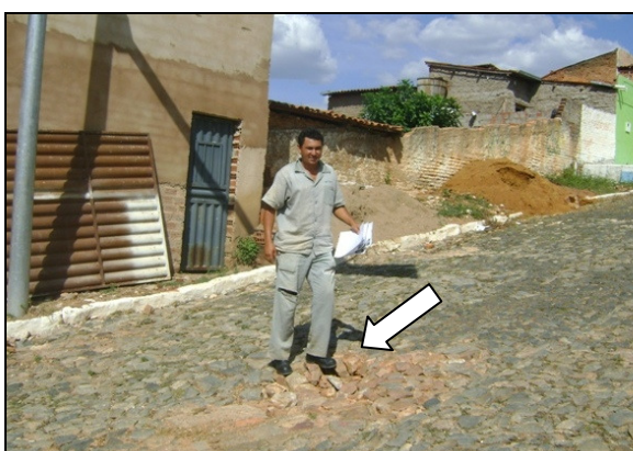
Foto 54 – Registro de descarga, sem caixa de proteção, localizado na Rua Liberalino Duarte de Brandão, Centro.
