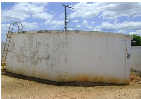
Foto 38 – Vista do RAP-01 e da escada de acesso.
