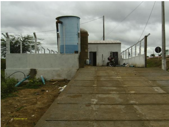
Foto 3 - ETA: ausência de portão na área de delimitação.
