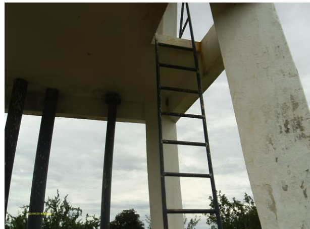
Foto 33 - REL-01: escada de acesso.
