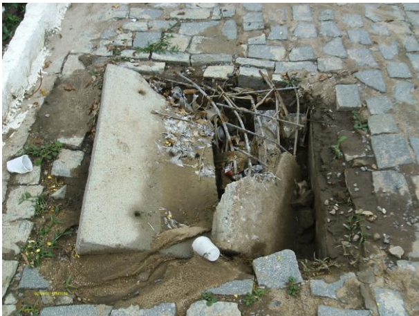
Foto 48 - Registro de descarga na rede de distribuição: Rua Tônico Nunes (tampa danificada).
