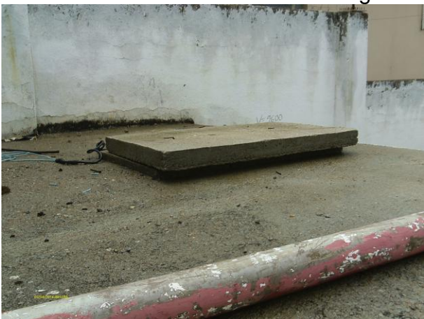
Foto 28 - RAP SDO: cobertura e tampa de inspeção.
