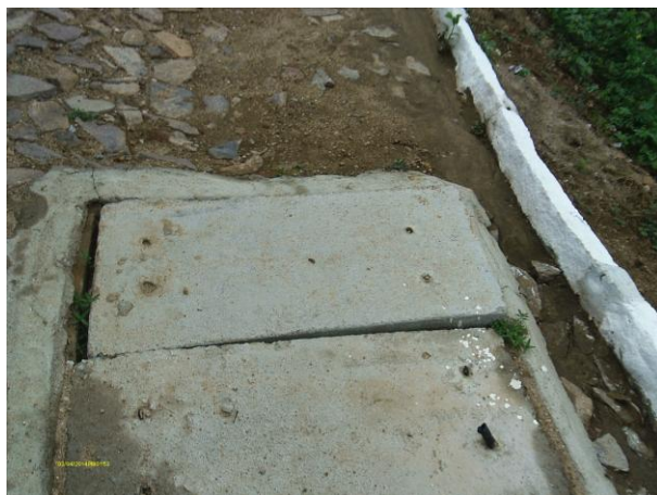
Foto 47 - Registro de descarga na rede de distribuição: Bairro Populares.
