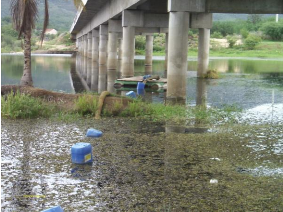
Foto 1 - Captação superficial: Rio Jaguaribe.
