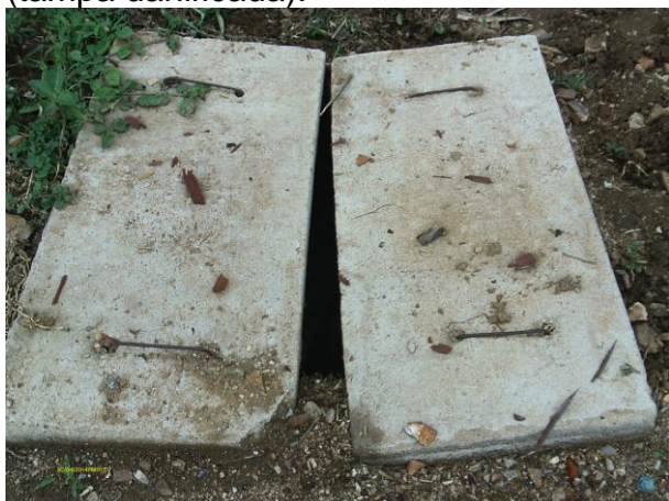
Foto 46 - Registro de descarga na rede de distribuição: Rua Raimundo Bezerra.
