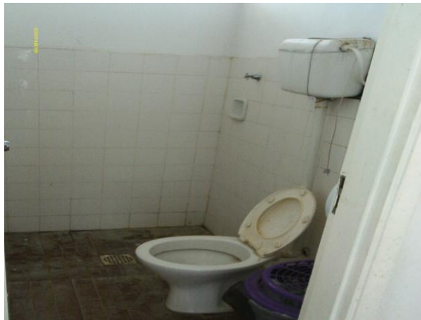
Foto 54 - Escritório: instalações sanitárias.
