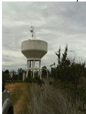
Foto 29 - REL-01: vista geral.
