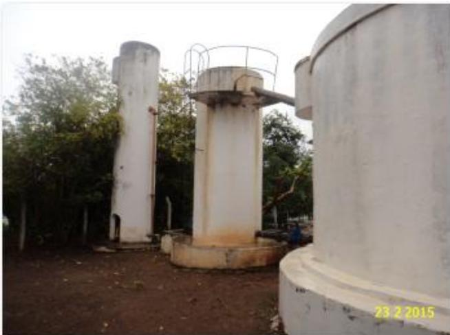
**Foto 1** – Filtro: ausência de guarda corpo na escada.
