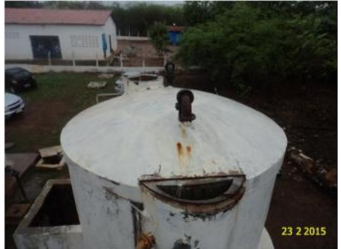
**Foto 4** – RAP-01: ausência de tampas de inspeção.
