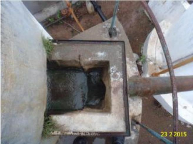
**Foto 3** – Filtro: ausência de tampa de inspeção na calha de água.
