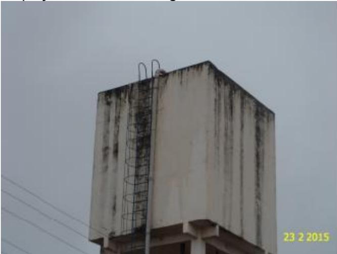
**Foto 5** – Ausência de guarda corpos na laje de cobertura, para-raios e sinalização noturna.
