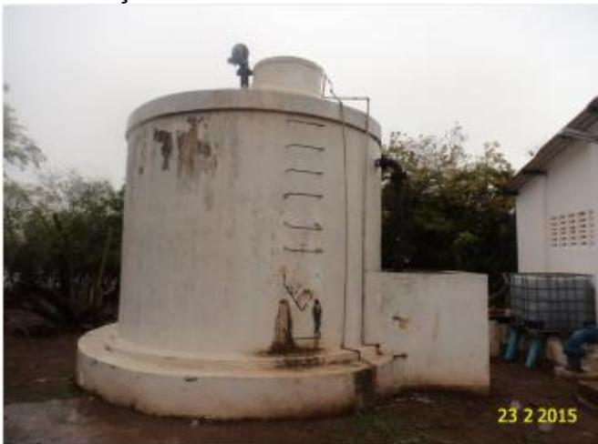
**Foto 10** – RAP-01: ausência de identificação; tubulação de ventilação sem tela de proteção; pintura e escada deterioradas.
