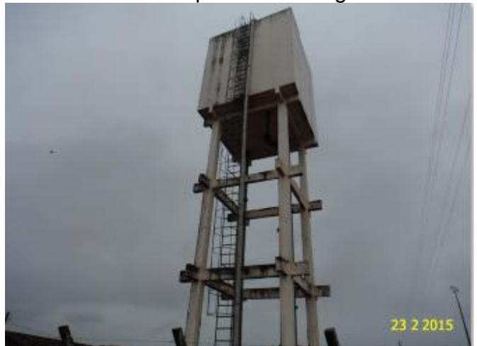
**Foto 11** – REL-01: ausência de identificação e pintura deteriorada.
