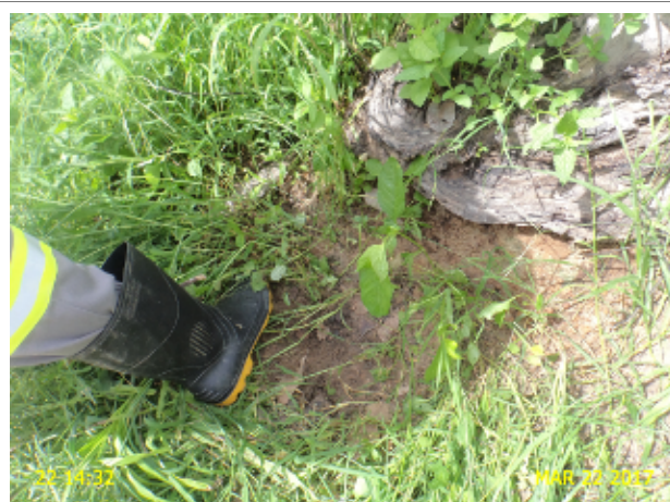
Foto 11 – RDA: registro de descarga soterrado na Rua da Esperança.
