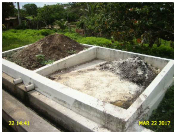
Foto 5 – ETE: leito de secagem com excesso de material retido do gradeamento e caixa de areia.
