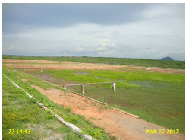
Foto 8 – ETE: presença de vegetação no interior das lagoas de maturação.
