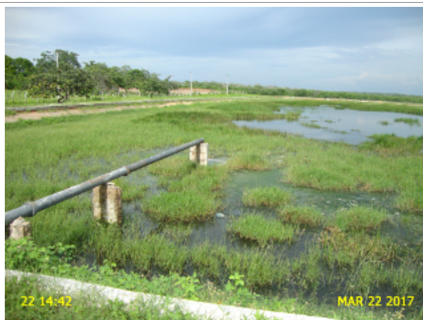
Foto 7 – ETE: presença de vegetação no interior da lagoa facultativa.
