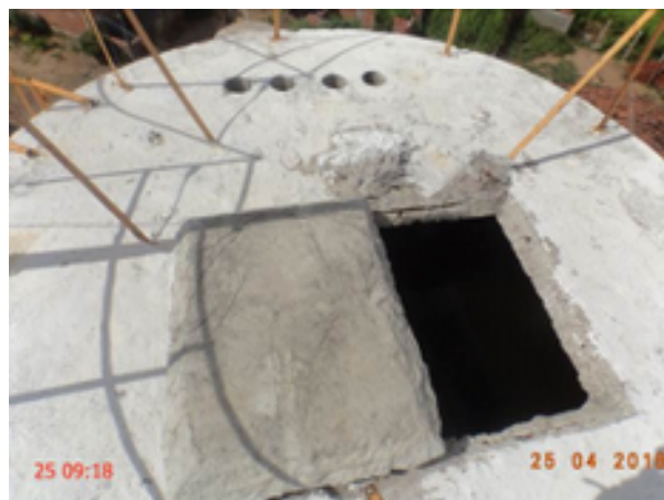
Foto 4 – REL-Sanharão: tampa de inspeção aberta, perfurações na laje de cobertura e ausência de tubulação de ventilação.
