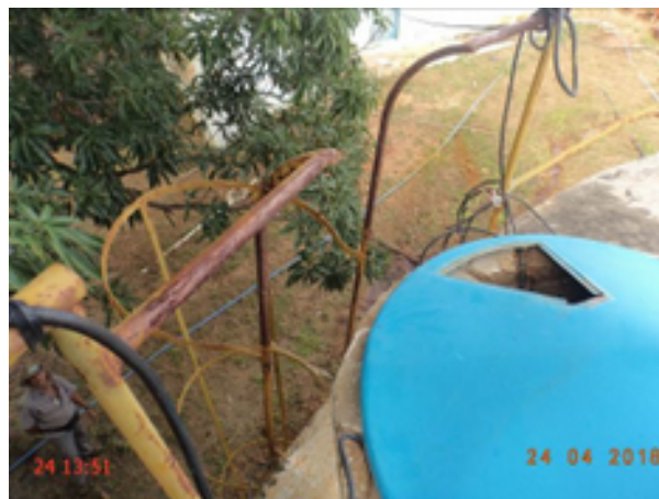
Foto 35 – RAP-01 (Sede): instalação elétrica inadequada do dispositivo de controle de nível.
