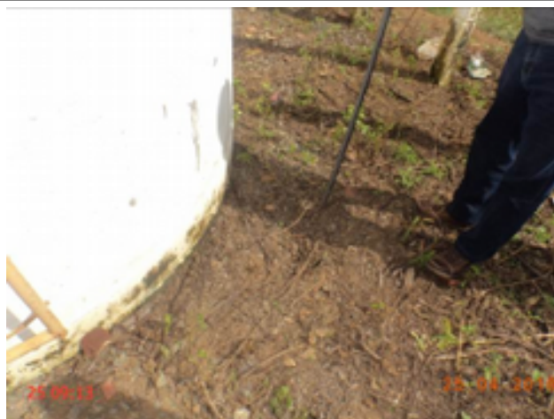
Foto 17 – REL-Sanharão: instalação de aterramento do para-raios danificado.
