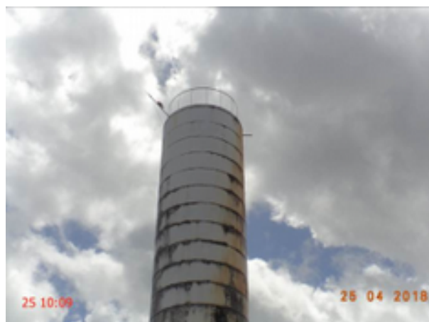
Foto 18 – REL-02 (Itamaracá) para-raios danificado e sinalização noturna de obstáculos com defeito.
