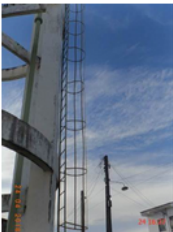
Foto 28 – REL-01 (Sede): guarda-corpo da escada de acesso sem condições de segurança.
