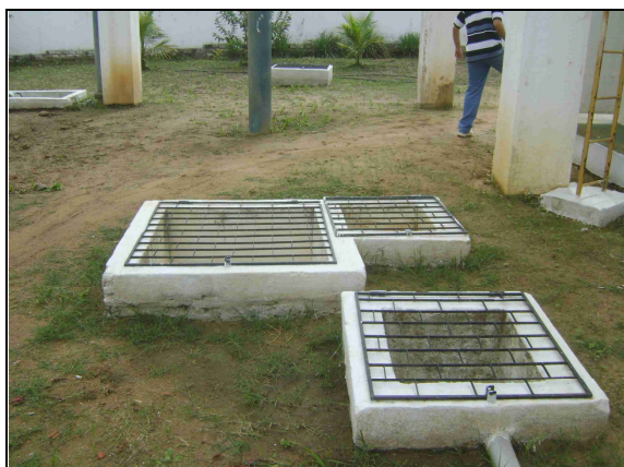
Foto 18 – REL-10: Todas as caixas de proteção da área de entorno apresentam grades.
