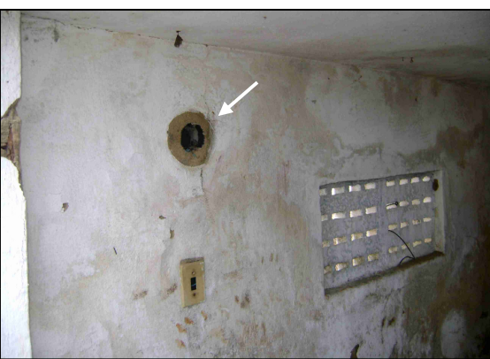
Foto 10 – Booster : Sem iluminação noturna.
