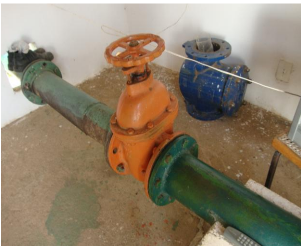
Foto 41 – Registro de água bruta no interior da casa de abrigo do QC da EECS.
