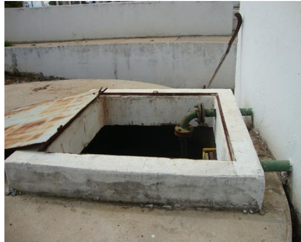
Foto 76 – Tampa de inspeção aberta do tanque de reuso.
