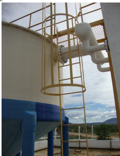
Foto 15 – Escada de acesso aos filtros, decantadores e floculadores com guarda-corpo
