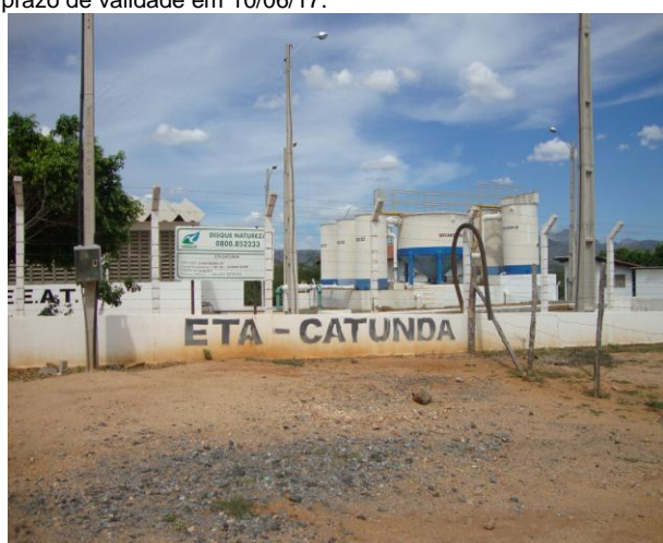
Foto 11 – Vista externa da ETA.
