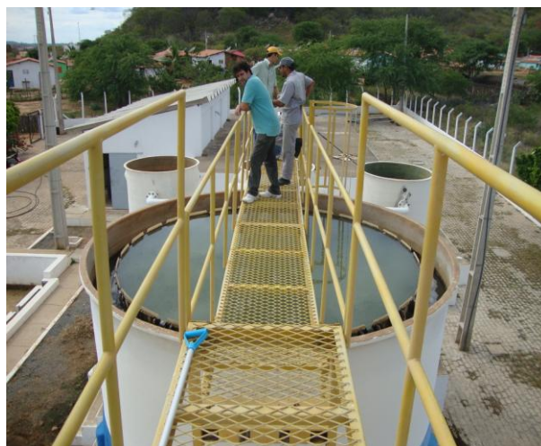
Foto 16 – Passarela com guarda-corpo de proteção no decantador.
