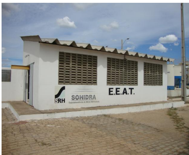
Foto 57 - Casa de abrigo das EEAT-01, EELF-01 e EEAT-02.
