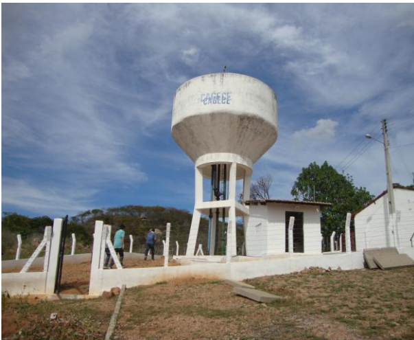
Foto 69 – Vista do REL-01 com iluminação e casa de química desativada.
