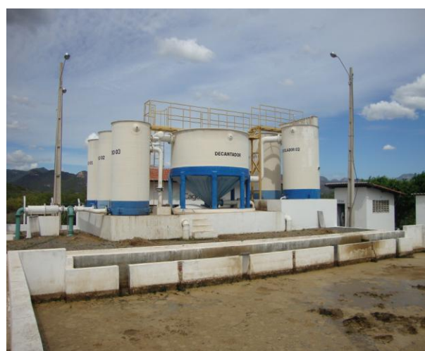
Foto 12 – Vista interna da ETA.
