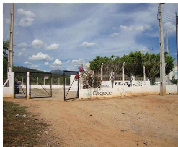
Foto 10 – Vista externa da ETA.
