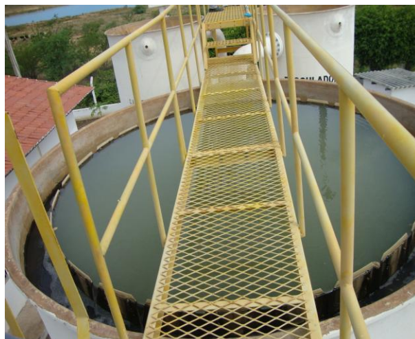
Foto 14 – Vista do decantador.
