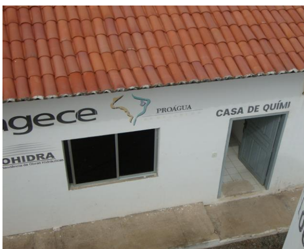
Foto 23 – Vista da casa de química.
