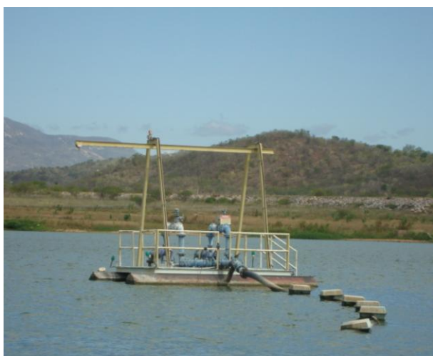
Foto 5 – Vista do flutuante da captação no Açude Carmina.
