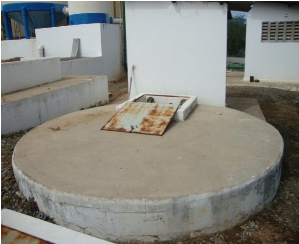
Foto 75 – Tanque de reuso no interior da ETA com tampa de inspeção aberta.
