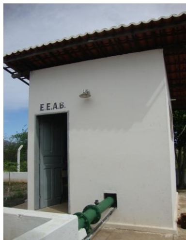
Foto 7 – Casa de abrigo do QC da EECS-01.
