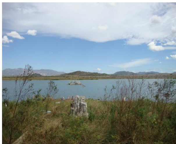
Foto 4 – Vista da captação no Açude Carmina.
