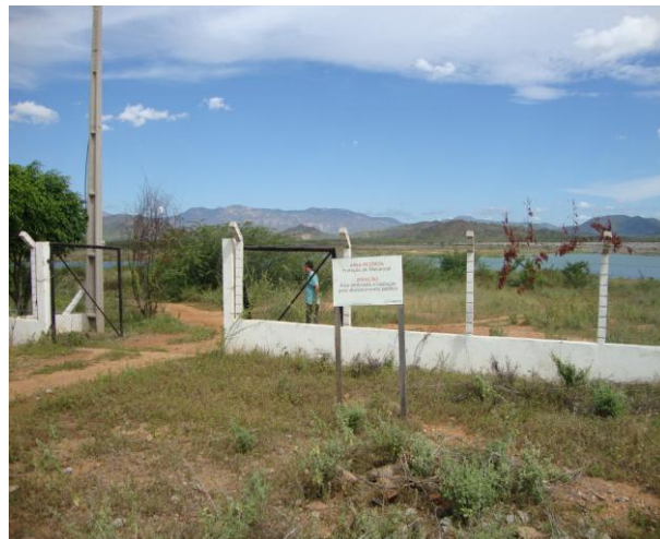
Foto 2 – Cerca de delimitação da área de captação.
