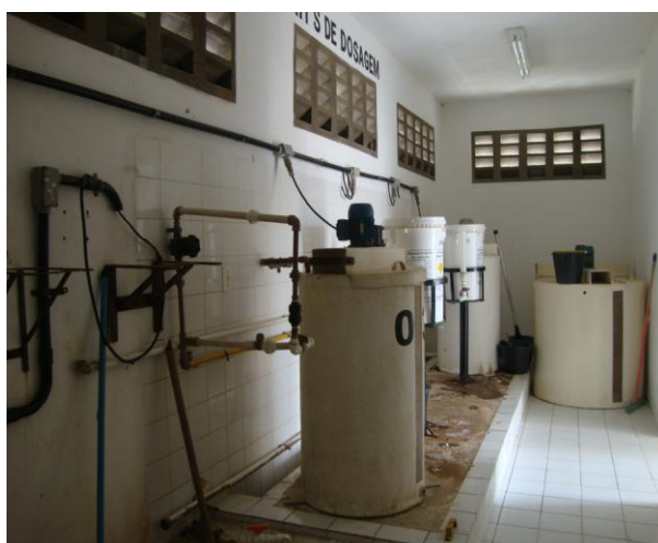
Foto 24 – Vista interna da casa de química.
