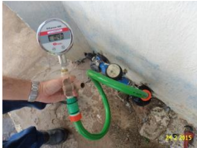
Foto 1 – RDA: medição de pressão instantânea.
