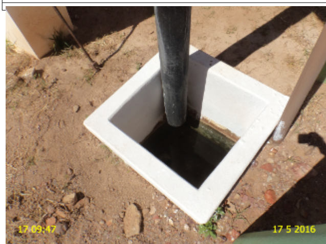
Foto 05 – RAP-04: tampa de inspeção sem vedação.
