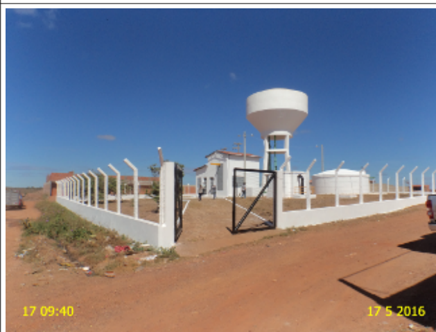
Foto 04 – REL-01: ausência de para-raios e de sinalizador noturno.
