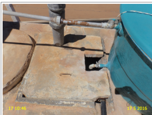
Foto 05 – RAP-04: tampa de inspeção sem vedação.
