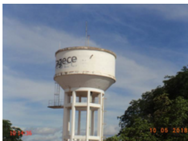
Foto 76 – RAP-18: pintura deteriorada/sem escada de acesso.
