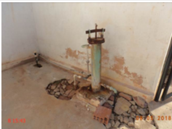
Foto 225 – PT-38: laje de proteção do clorador danificada e em processo de corrosão.
