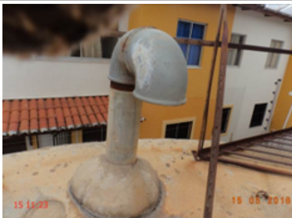
Foto 169 – RAP-24: tubulação de ventilação sem tela de proteção.
