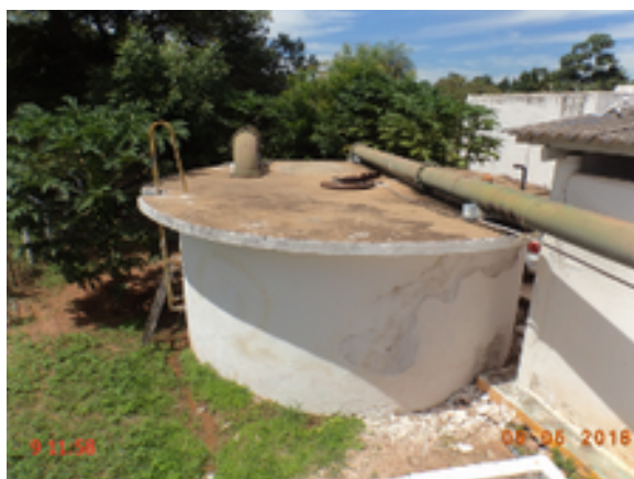
Foto 183 – RAP-Timbaúba (1): tampa de inspeção não está devidamente fechada.
