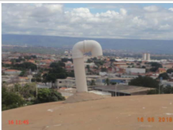
Foto 169 – RAP-24: tubulação de ventilação sem tela de proteção.
