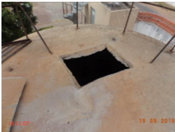
Foto 193 – RAP-25: tampa de inspeção aberta.
