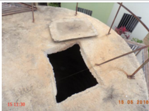
Foto 190 – RAP-21: tampa de inspeção aberta.
