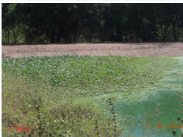
Foto 197 – ETE Malvas: acúmulo de sobrenadantes LF(1).
