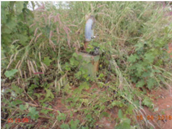
Foto 109 – PT-35: sem identificação e com defeito
