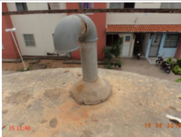
Foto 164 – RAP-19: tubulação de ventilação sem tela de proteção.
