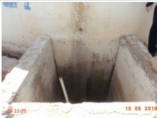
Foto 94 – RAP-18: caixa de inspeção sem tampa ou grade de proteção.
