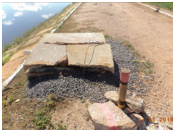
Foto 146 – ETE Malvas: caixa de inspeção danificada na LAN (1).
