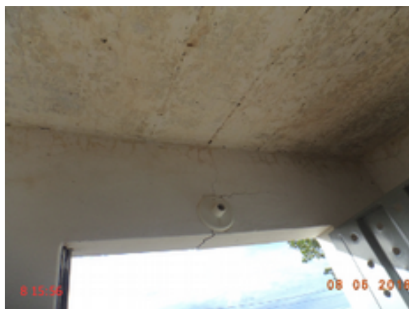
Foto 278 – PT-41: sem lâmpada na casa de abrigo do quadro de comando.
