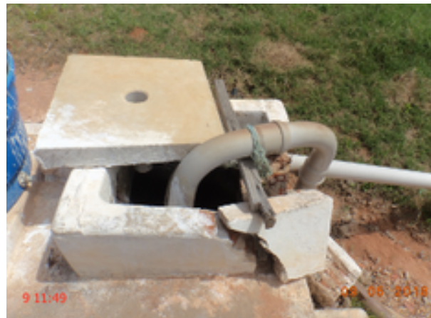
Foto 184 – RAP-09: tampa de inspeção sem vedação e com base danificada.
