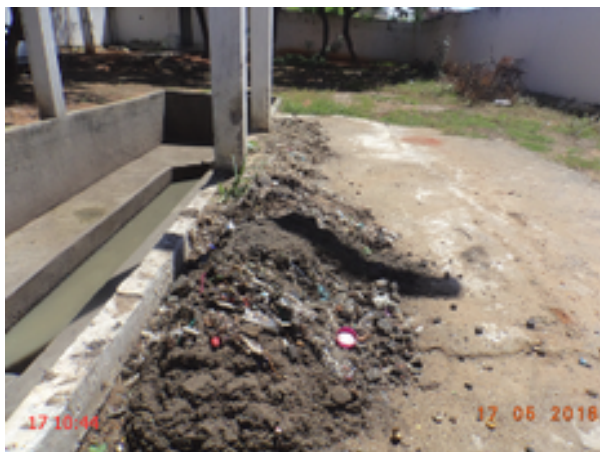
Foto 21 – ETP Paraná: não existe leito de secagem.
