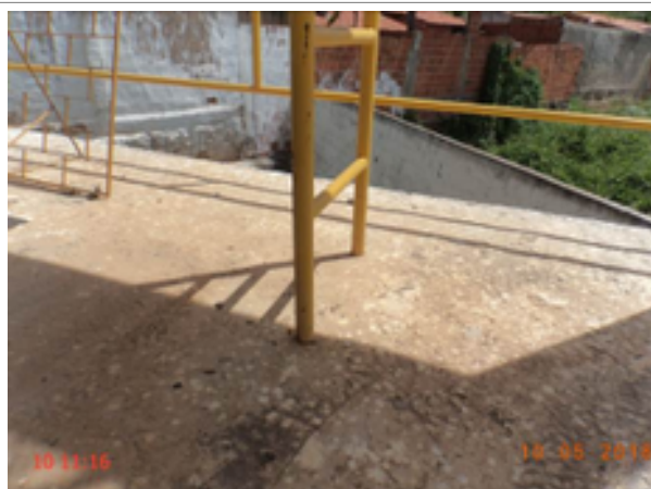
Foto 208 – REL-06: guarda-corpo da escada de acesso danificado.
