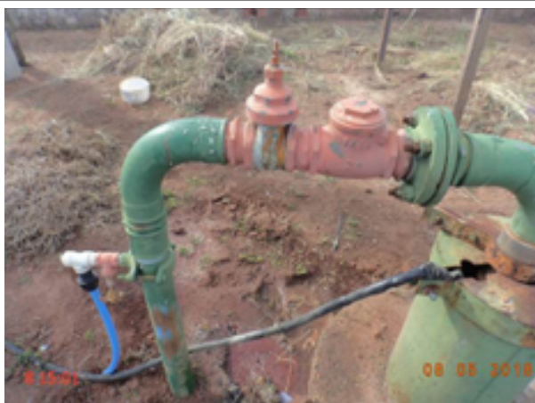
Foto 225 – PT-38: laje de proteção do clorador danificada e em processo de corrosão.
