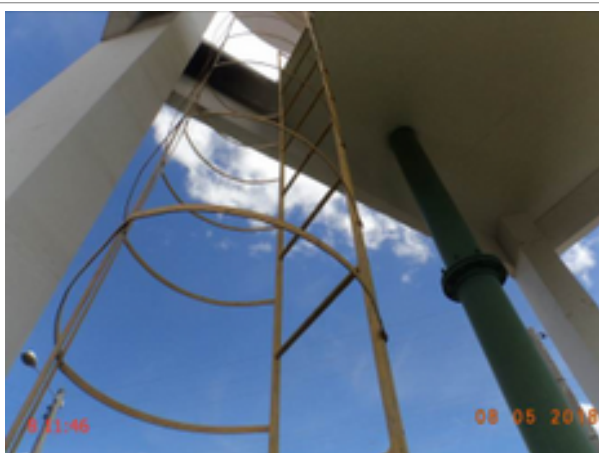
Foto 207 – REL-04: guarda-corpo da escada de acesso danificado.
