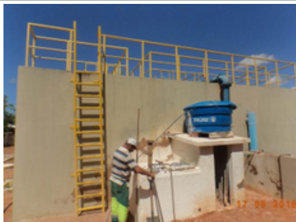
Foto 200 – ETE MCMV Tenente Coelho: decantadores sem identificação.
