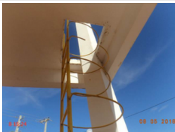
Foto 206 – RAP-05: escada sem apoio para acessar a laje de cobertura do reservatório.
