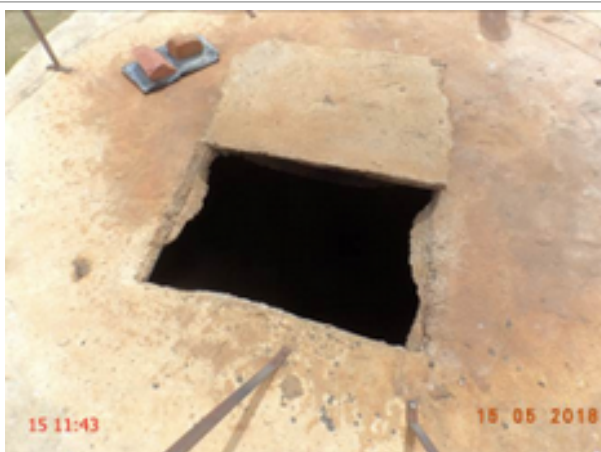
Foto 189 – RAP-20: tampa de inspeção aberta.
