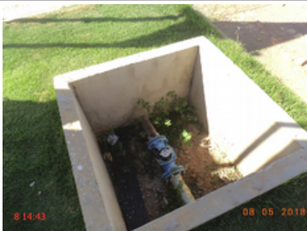
Foto 235 – PT-44: caixa de inspeção sem tampa ou grade de proteção.
