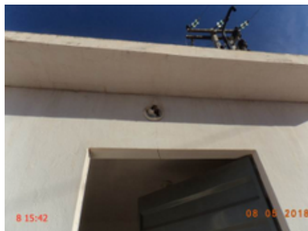
Foto 262 – PT-38: ausência de lâmpada na área externa da casa de abrigo do quadro de comando.
