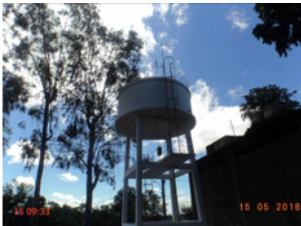
Foto 67 – REL-03: ausência de identificação.
