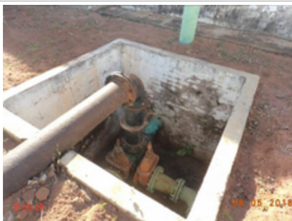
Foto 98 – RAP-Timbaúba (2): caixa do registro sem tampa ou grade de proteção.
