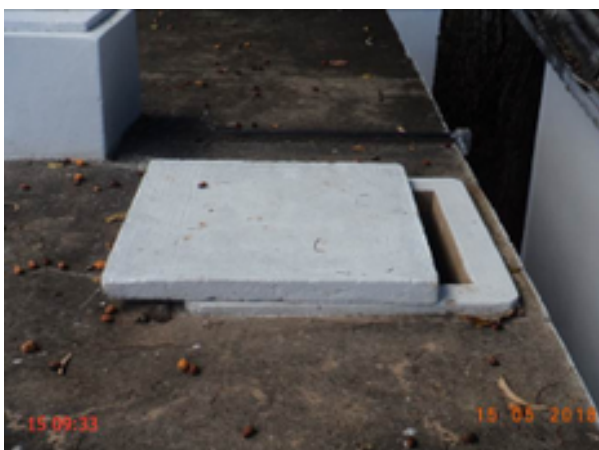
Foto 183 – RAP-Timbaúba (1): tampa de inspeção não está devidamente fechada.
