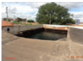
Foto 87 – RAP-04: acúmulo de águas pluviais na laje de cobertura.
