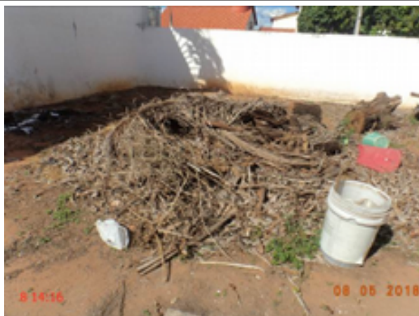
Foto 26 – RAP-06: acúmulo de lixo na área do reservatório.
