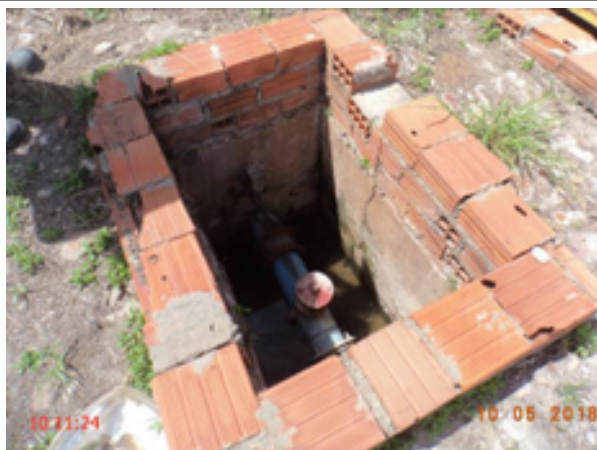
Foto 94 – RAP-18: caixa de inspeção sem tampa ou grade de proteção.
