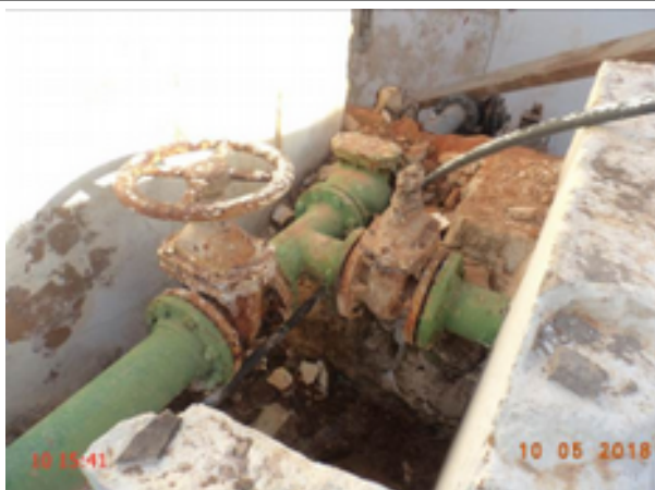
Foto 43 – RAP-12: vazamento no registro de saída de água.
