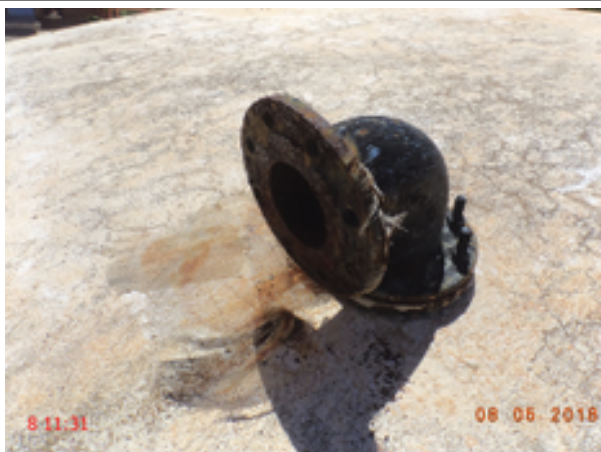
Foto 163 – RAP-16: tubulação de ventilação sem tela de proteção.
