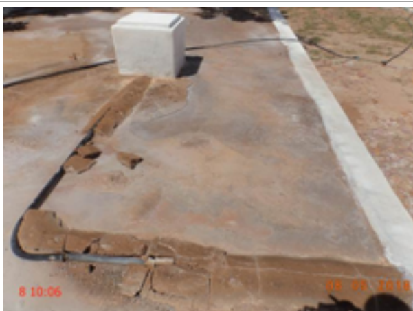
Foto 85 – RAP-Timbaúba (2): reboco da laje de cobertura danificada.
