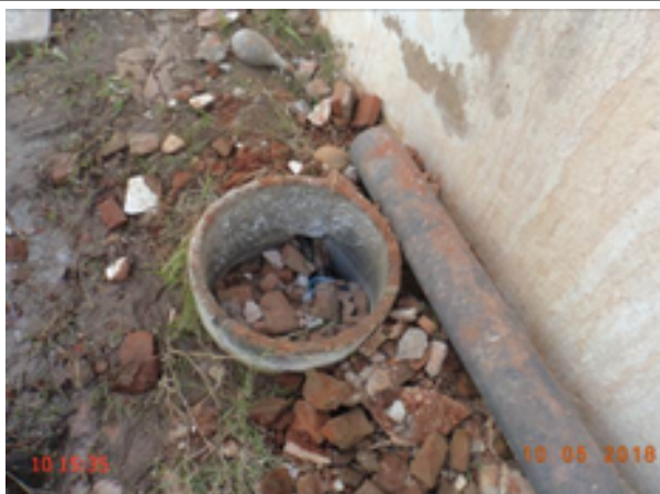
Foto 93 – RAP-12: caixa de inspeção sem tampa ou grade de proteção.
