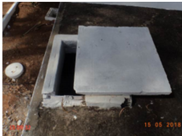
Foto 184 – RAP-09: tampa de inspeção sem vedação e com base danificada.
