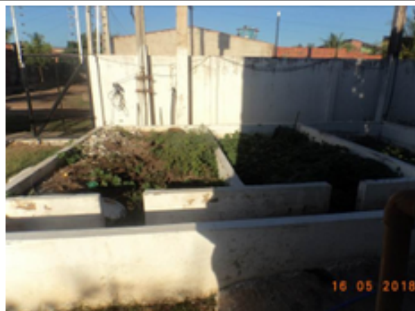
Foto 158 – ETE Vila Três Marias: acúmulo de lodo e vegetação em excesso nos leitos de secagem.
