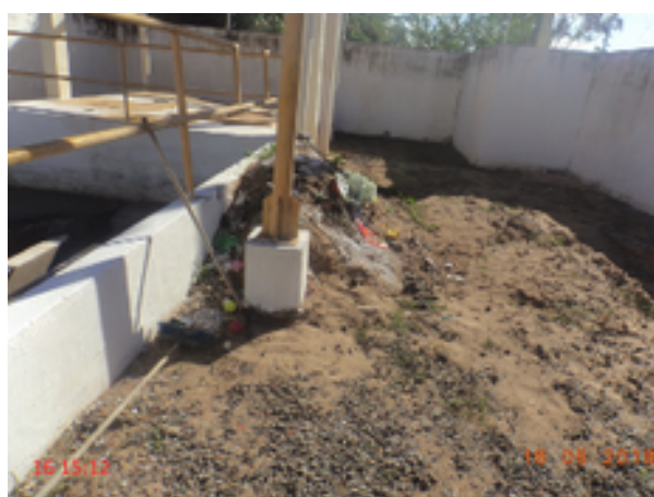
Foto 20 – EEE MCMV Manoel Santana: não existe leito de secagem.
