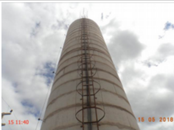
Foto 211 – REL-07: ausência de identificação/escada em corrosão/guarda-corpo parcialmente não instalado.
