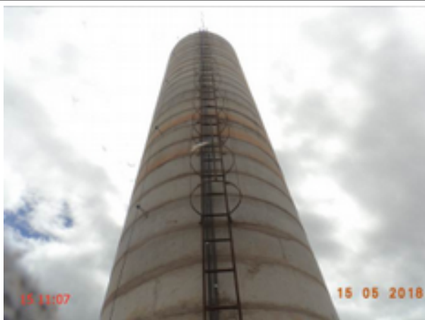
Foto 217 – REL-13: ausência de identificação/escada em corrosão/guarda-corpo parcialmente não instalado.
