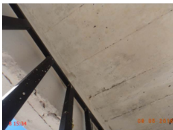
Foto 263 – PT-39 – ausência de lâmpada na parte interna da casa de abrigo do quadro de comando.
