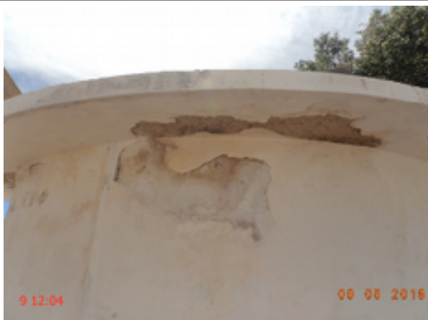
Foto 85 – RAP-Timbaúba (2): reboco da laje de cobertura danificada.
