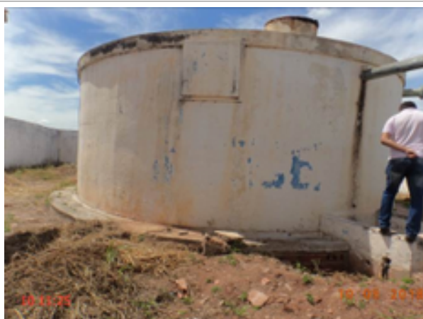
Foto 76 – RAP-18: pintura deteriorada/sem escada de acesso.
