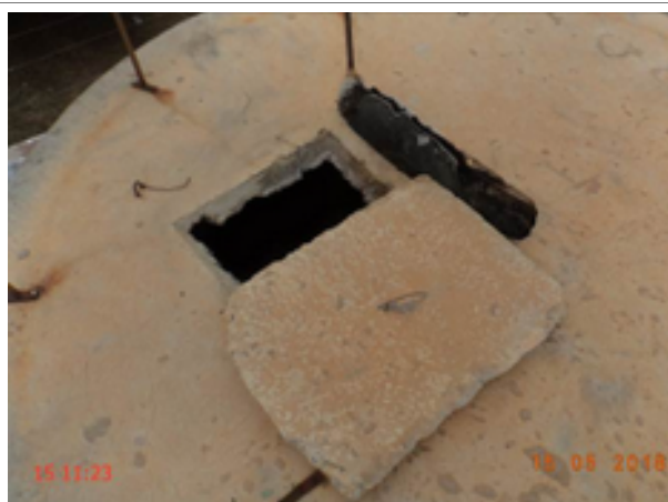
Foto 192 – RAP-24: tampa de inspeção aberta.
