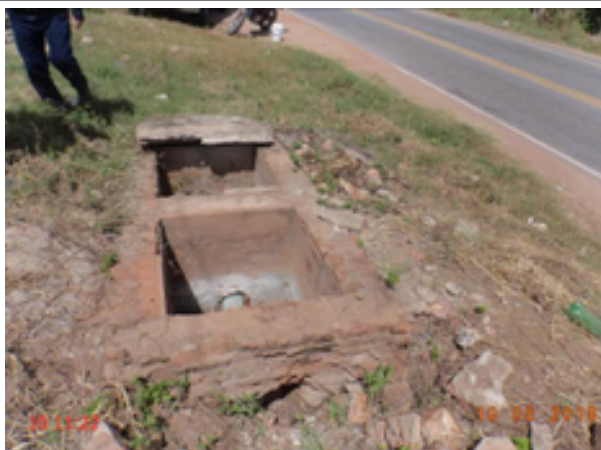
Foto 93 – RAP-12: caixa de inspeção sem tampa ou grade de proteção.
