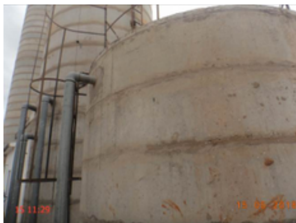
Foto 62 – RAP-21: ausência de identificação/escada de acesso em corrosão/guarda-corpo em corrosão.
