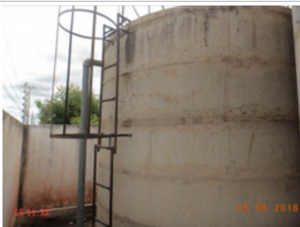
Foto 63 – RAP-22: ausência de identificação/escada de acesso em corrosão/guarda-corpo em corrosão.
