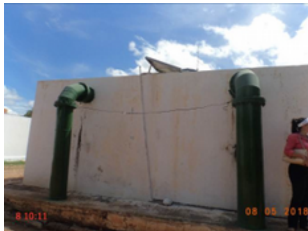
Foto 56 – RAP-05: sem identificação e pintura deteriorada.
