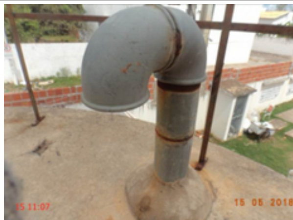
Foto 170 – RAP-25: tubulação de ventilação sem tela de proteção.
