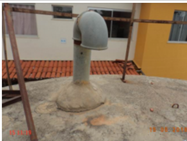
Foto 166 – RAP-21: tubulação de ventilação sem tela de proteção.
