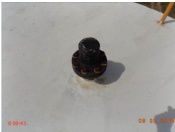
Foto 55 – REL-17: tubulação de ventilação inadequada.
