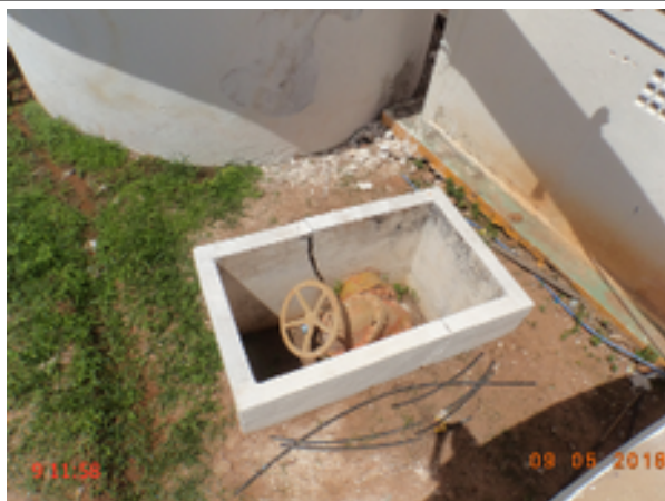
Foto 98 – RAP-Timbaúba (2): caixa do registro sem tampa ou grade de proteção.
