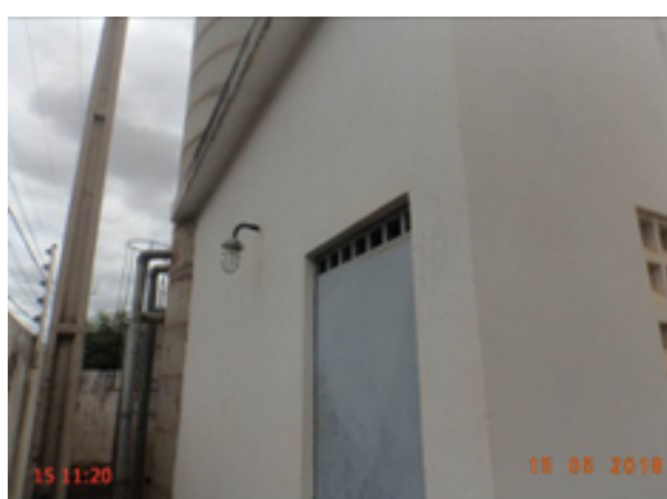
Foto 40 – EEAT-21: ausência de identificação.
