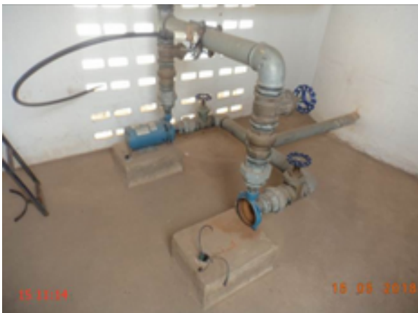
Foto 15 – EEAT-20 (MCMV TC 03): apenas uma bomba instalada.
