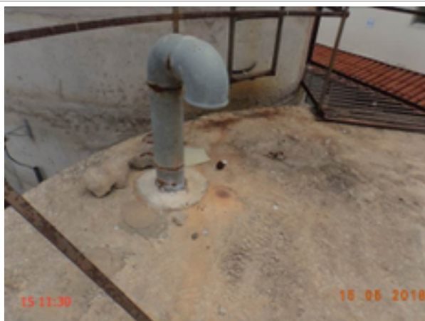
Foto 164 – RAP-19: tubulação de ventilação sem tela de proteção.
