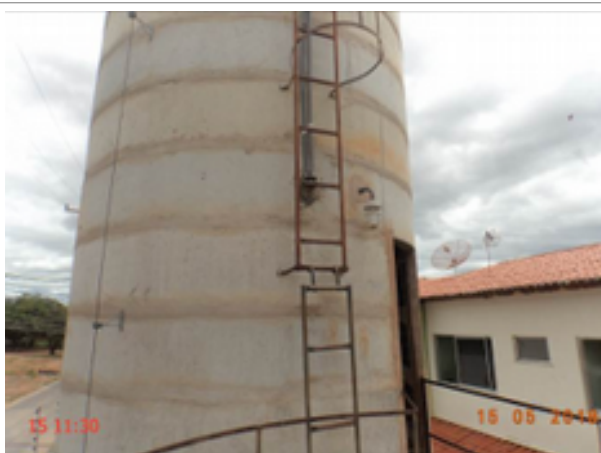
Foto 211 – REL-07: ausência de identificação/escada em corrosão/guarda-corpo parcialmente não instalado.
