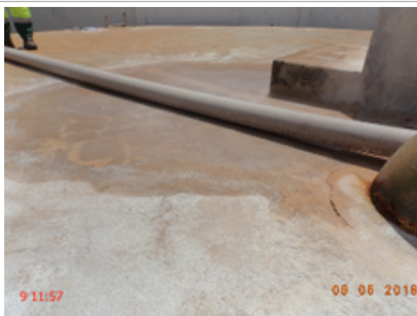
Foto 86 – RAP-02/RAP-03: acúmulo de águas pluviais na laje de cobertura.
