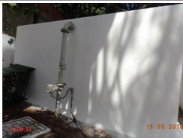
Foto 56 – RAP-05: sem identificação e pintura deteriorada.
