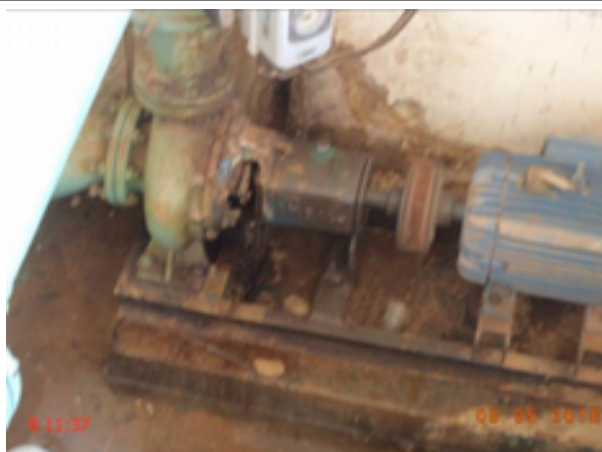
Foto 121 – EEAT-11: vazamento na gaxeta da bomba.
