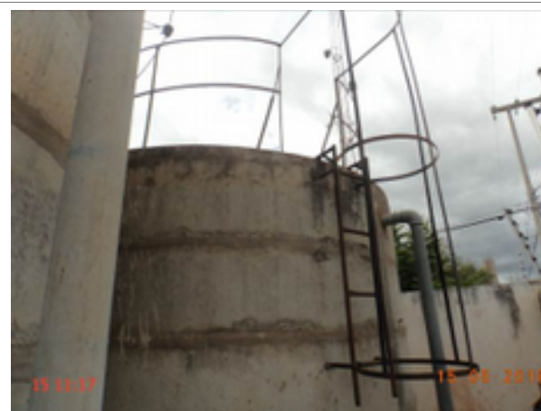
Foto 62 – RAP-21: ausência de identificação/escada de acesso em corrosão/guarda-corpo em corrosão.
