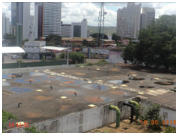
Foto 86 – RAP-02/RAP-03: acúmulo de águas pluviais na laje de cobertura.
