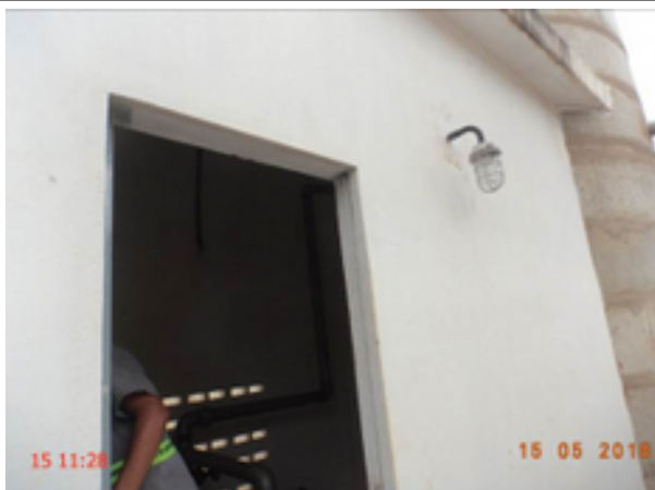
Foto 37 – EEAT-18: ausência de identificação.
