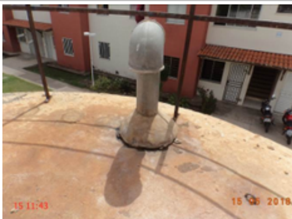
Foto 163 – RAP-16: tubulação de ventilação sem tela de proteção.
