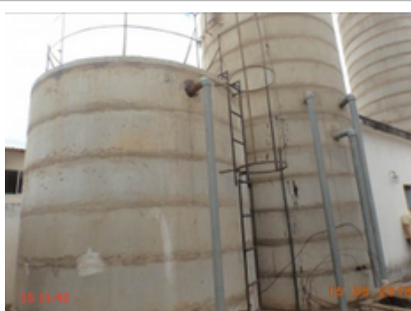
Foto 64 – RAP-23: ausência de identificação/escada de acesso em corrosão/guarda-corpo em corrosão.
