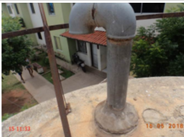
Foto 165 – RAP-20: tubulação de ventilação sem tela de proteção.
