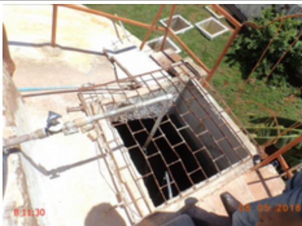
Foto 187 – RAP-16: tampa de inspeção aberta.
