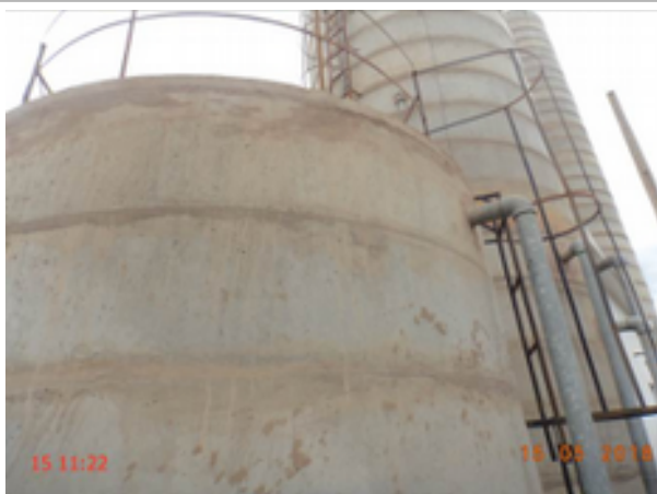
Foto 63 – RAP-22: ausência de identificação/escada de acesso em corrosão/guarda-corpo em corrosão.
