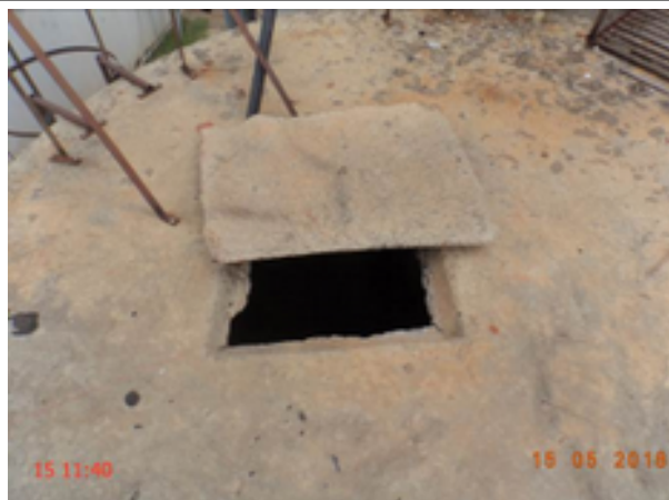
Foto 188 – RAP-19: tampa de inspeção aberta.
