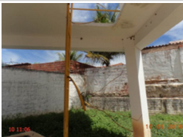
Foto 207 – REL-04: guarda-corpo da escada de acesso danificado.
