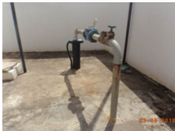
Foto 114 – PT-Belo Monte (parte alta): sem identificação.
