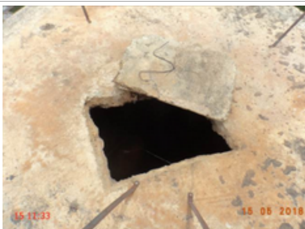
Foto 191 – RAP-22: tampa de inspeção aberta.
