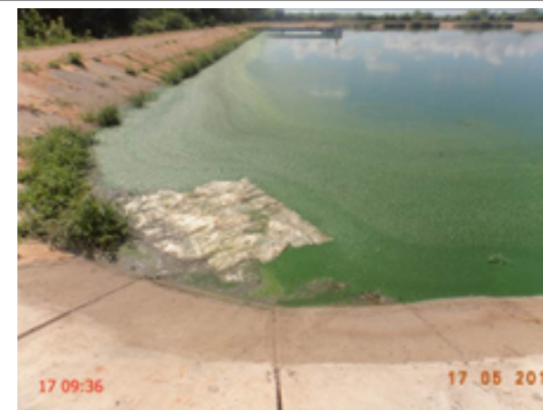
Foto 198 – ETE Malvas: acúmulo de sobrenadantes LF(2).
